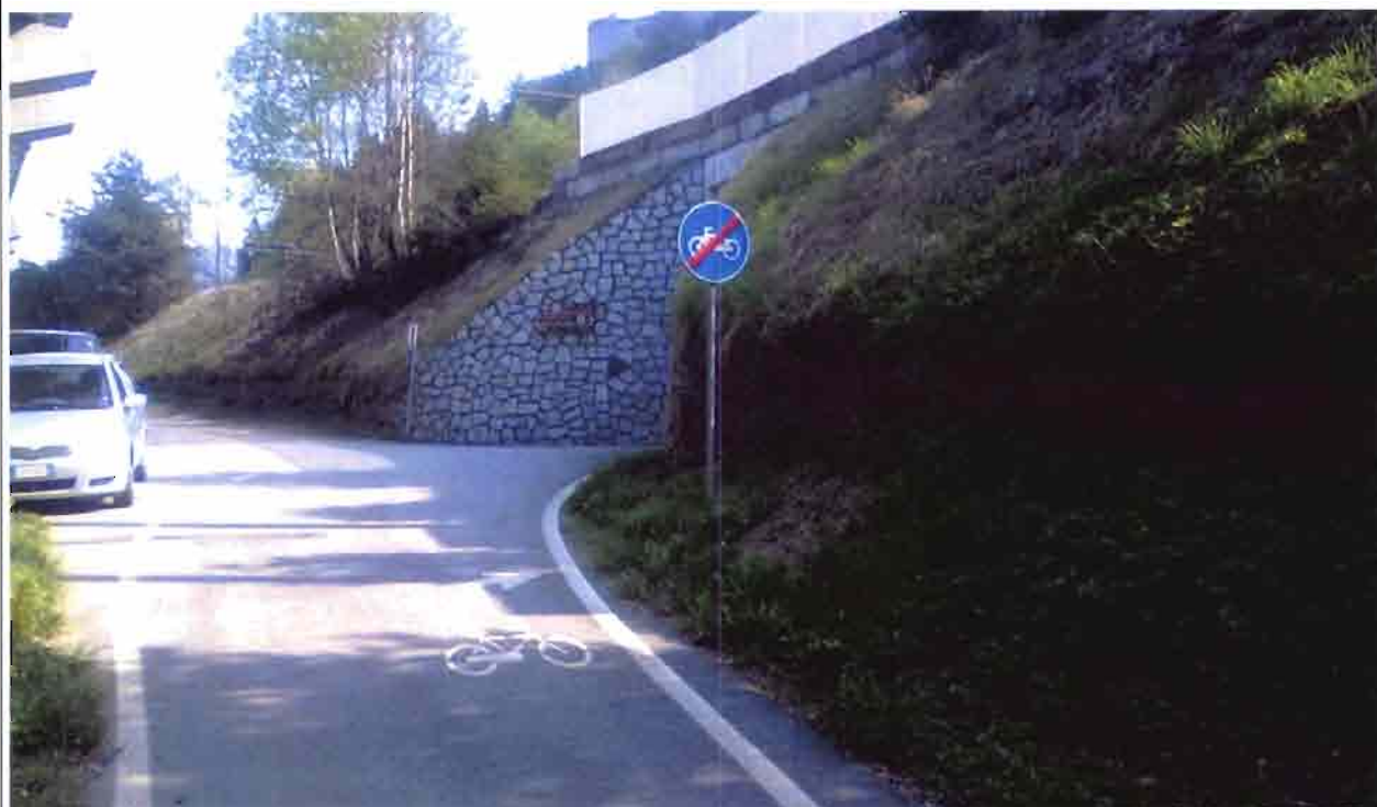
Strada podereale in corrispondenza del sottopasso ferroviario
