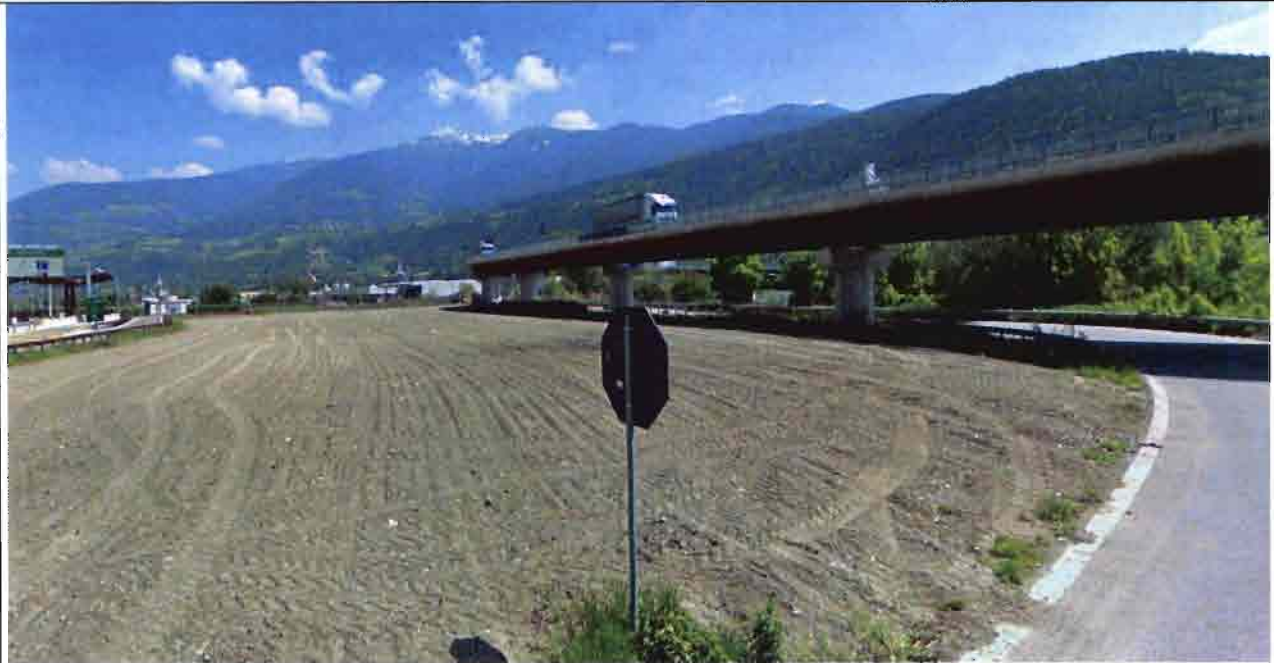
Accesso all'area di cantiere
