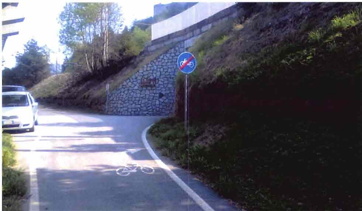
Strada podereale in corrispondenza del sottopasso ferroviario
