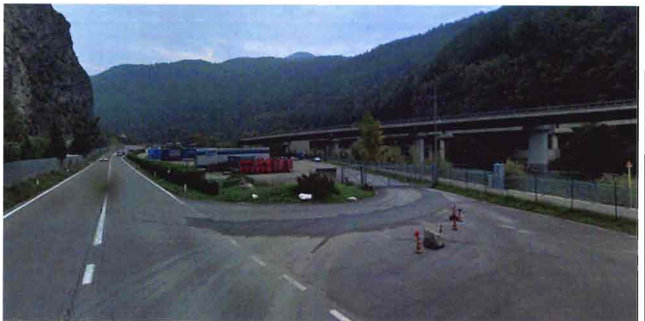
Accesso all'area di cantiere
