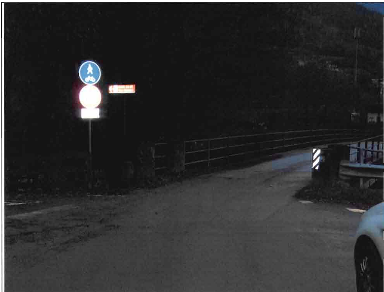
Ponte esistente per superare il fiume Isarco
