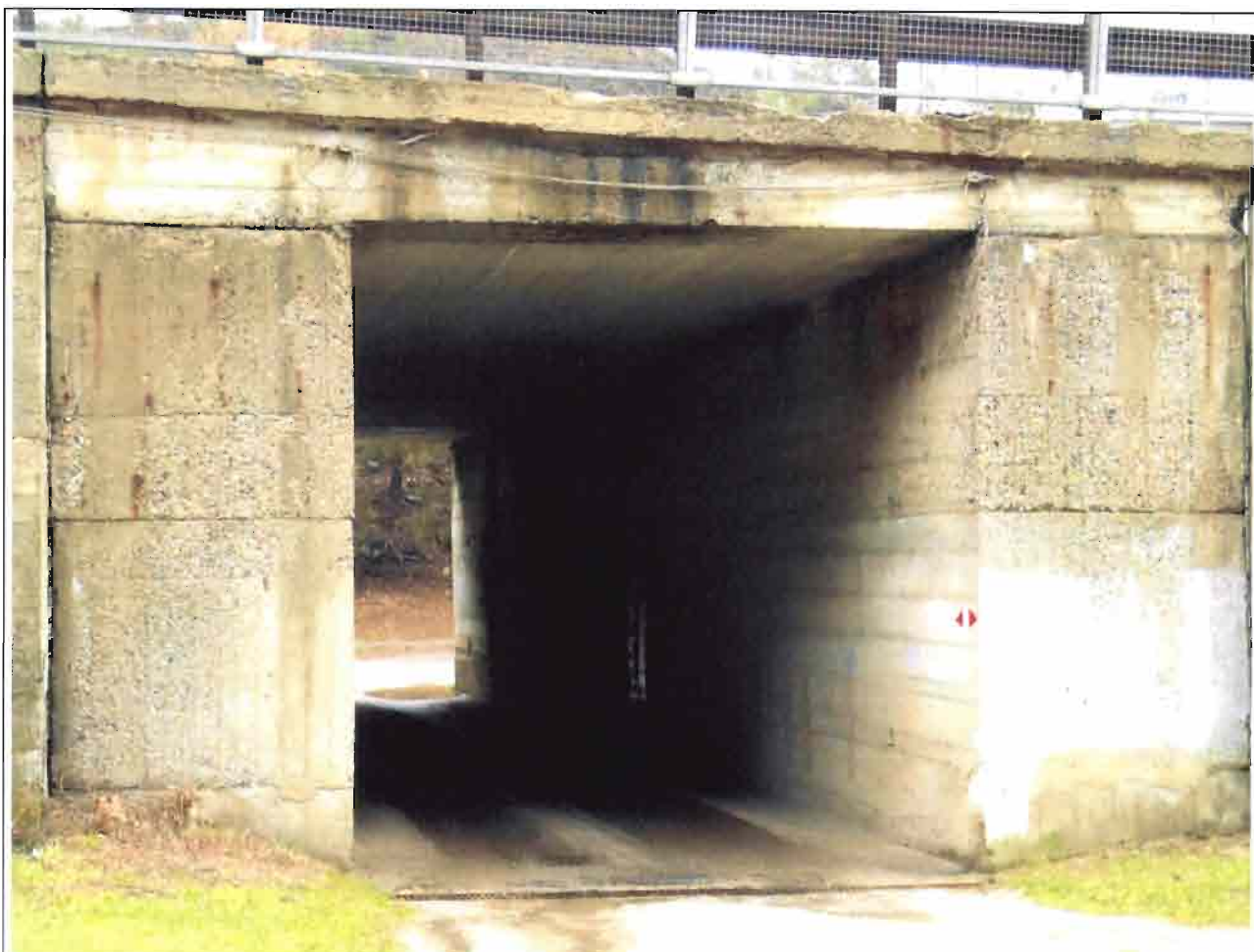
Sottovia esistente per accesso all'area di stoccaggio temporanea A.S.02C
