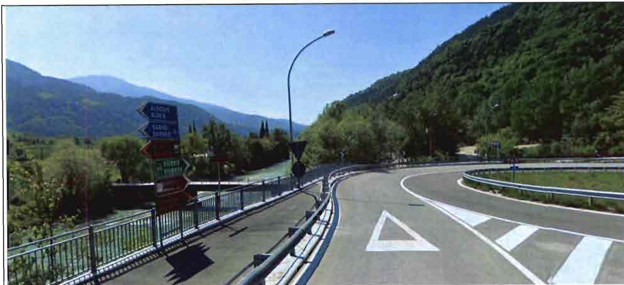
Uscita in direzione depuratore
