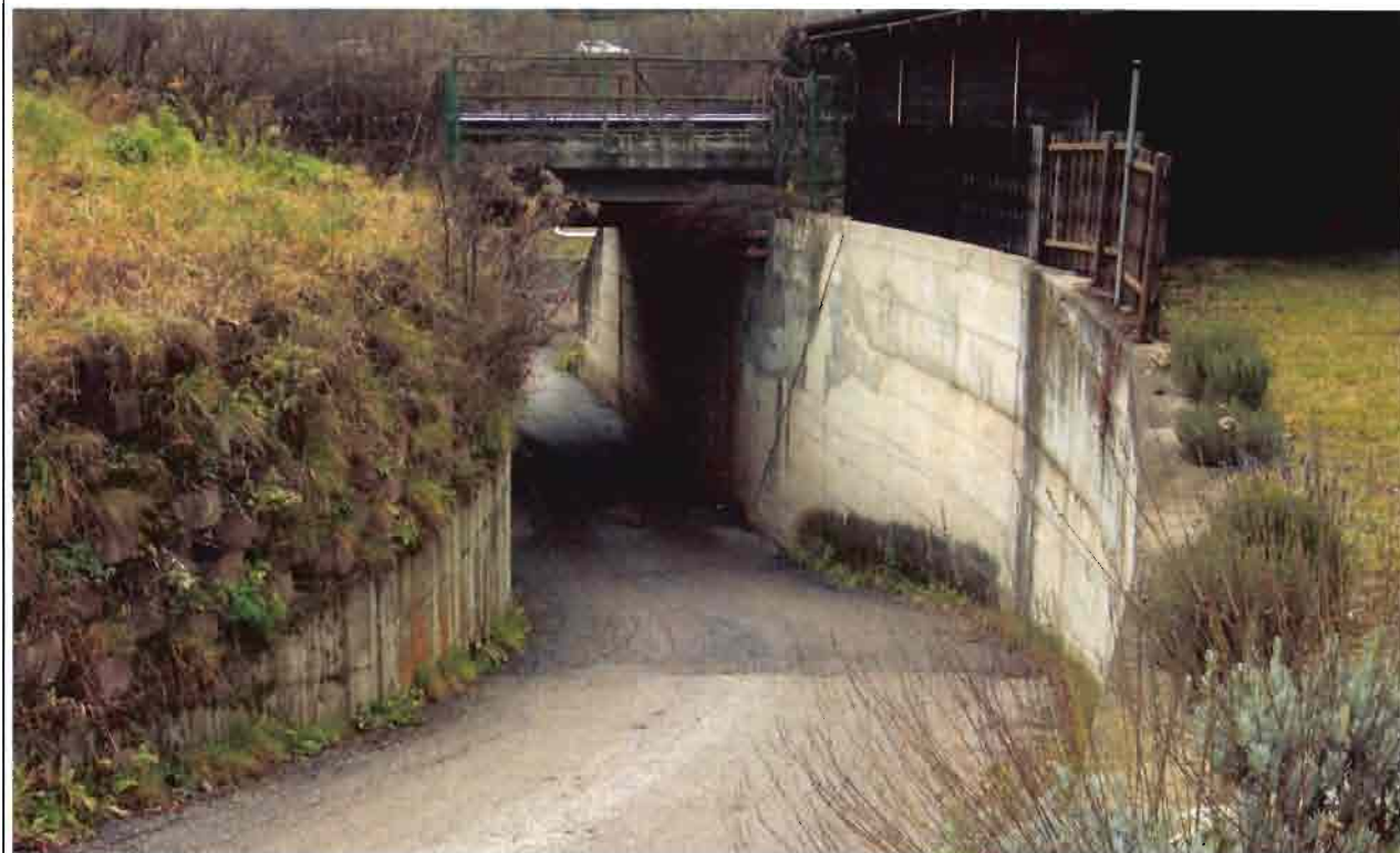
Sottovia esistente per accesso al cantiere base C.B.04
