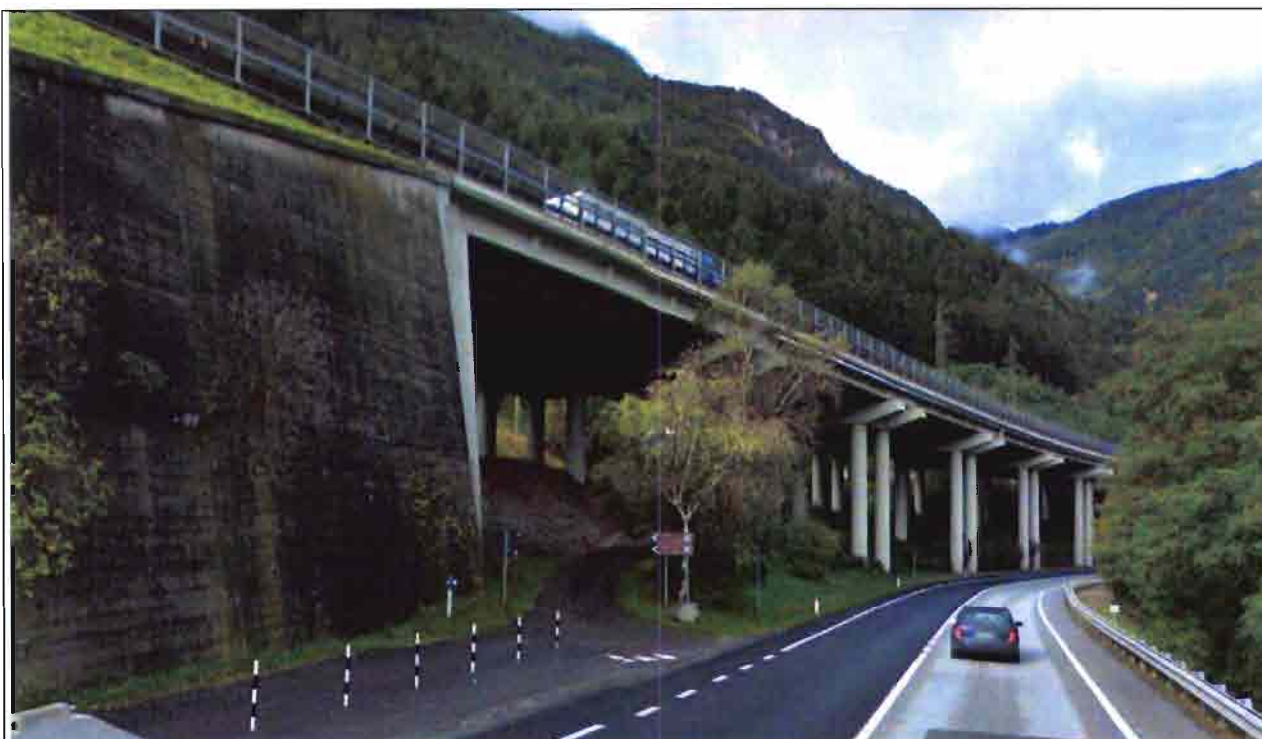
Accesso alla strada podereale per raggiungere l'area di stoccaggio temporanea A.S.01
