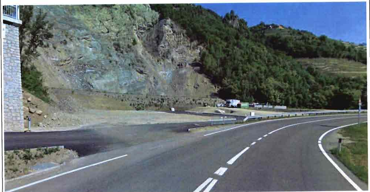
Deviazione a sinistra sulla strada poderale di accesso
