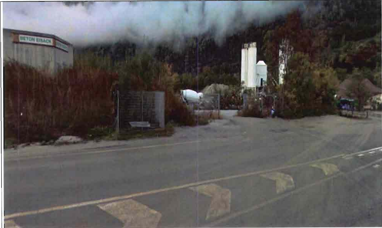
Possibile ingresso all'area A.S.02.B in corrispondenza della Ditta di Betonaggio.
