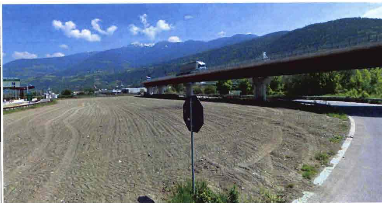
Accesso all'area di cantiere
