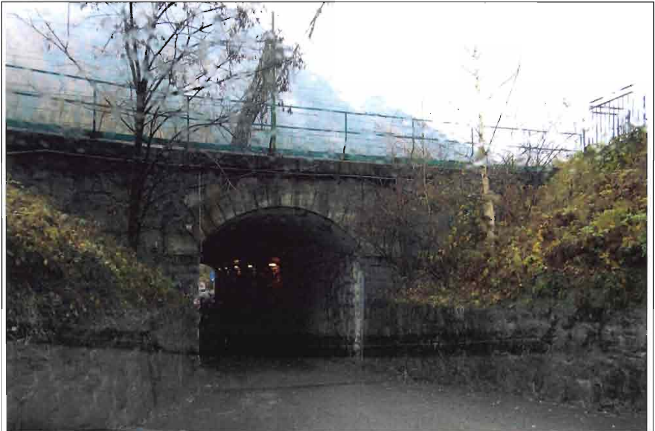
Sottopasso in via Rioli esistente
