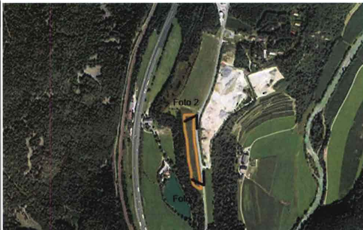
Vista aerea della A.T.02B
