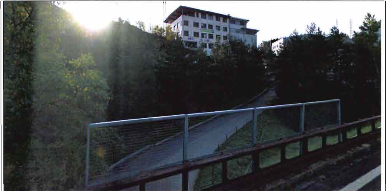
Vista della futura pista di cantiere dalla A22 8 (verso Nord).
