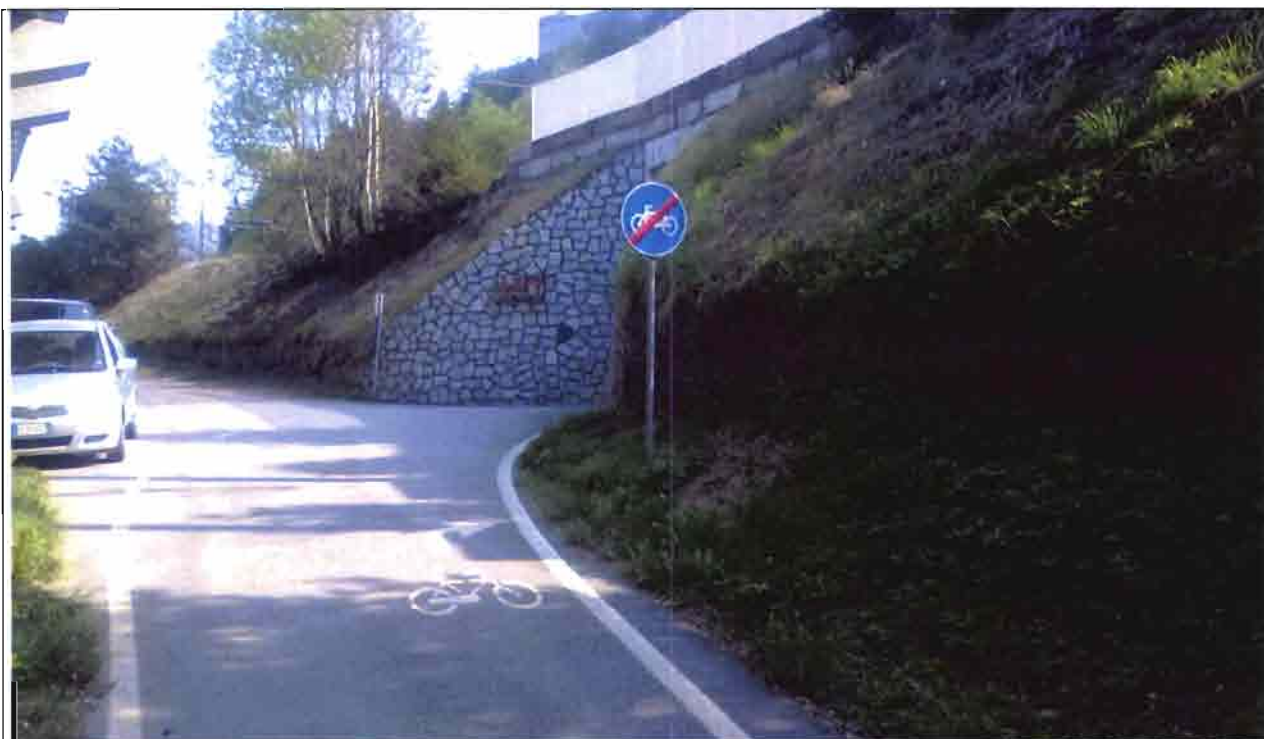
Strada podereale in corrispondenza del sottopasso ferroviario
