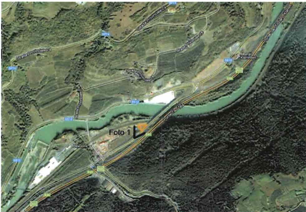
Vista aerea della A.T.04B
