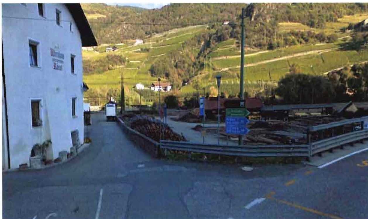
Svincolo a fianco della falegnameria
