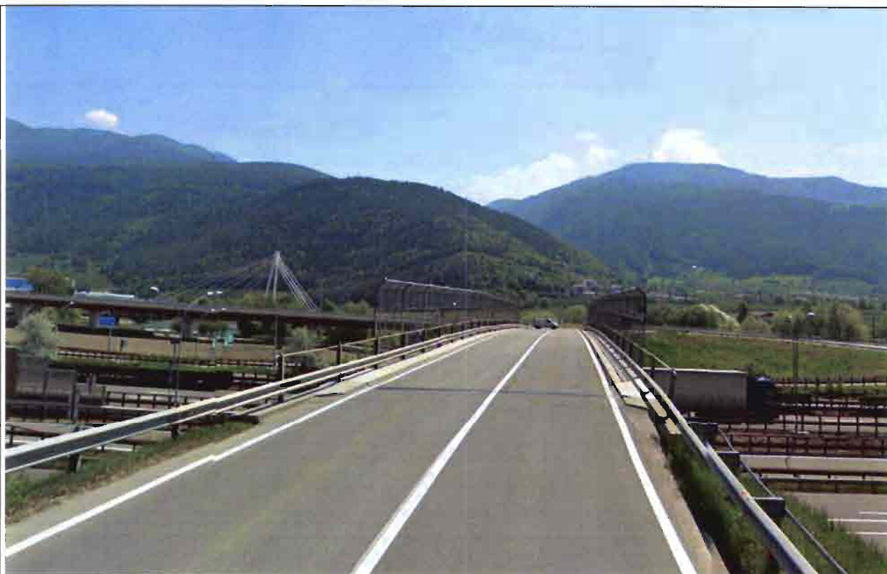
Ponte esistente per superare l'autostrada A22
