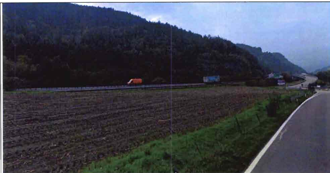
Accesso all'area di cantiere
