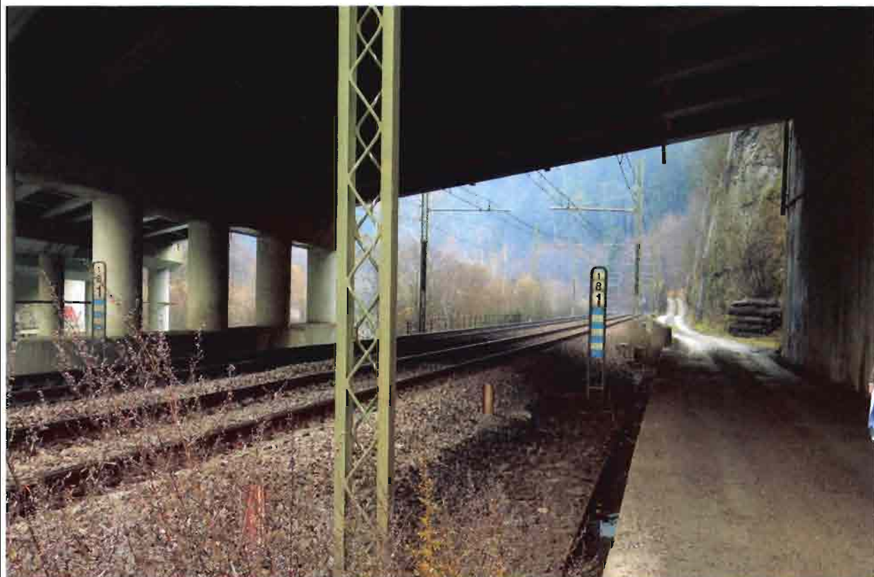
Strada poderale da adeguare per accesso all'area di stoccaggio A.S.04
