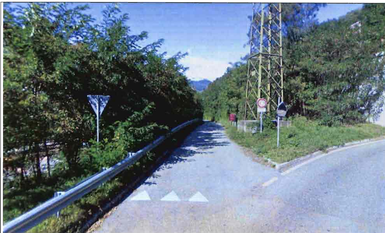
Accesso alla strada poderale dalla S.P. n.82
