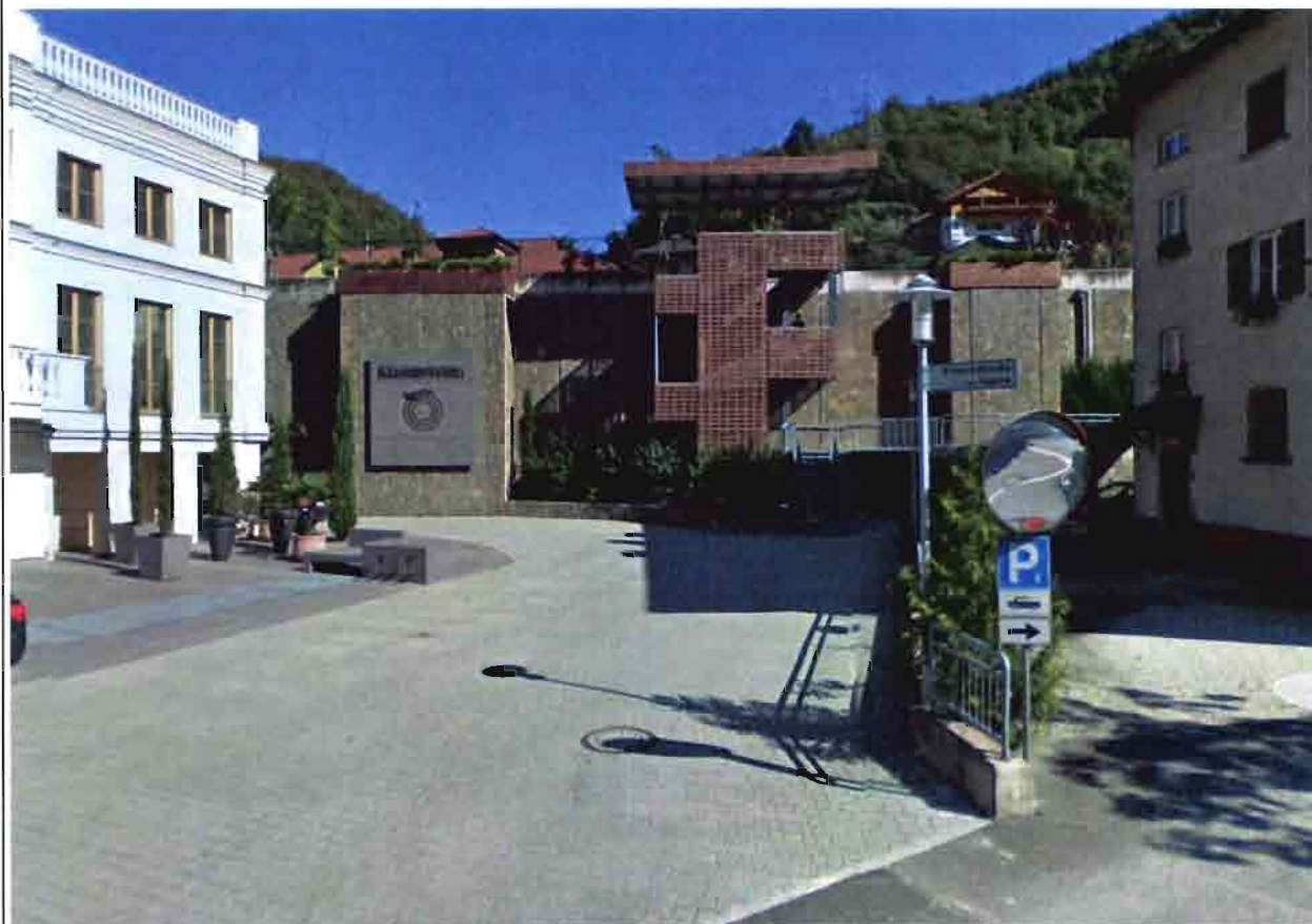
Punto di accesso da area privata.
