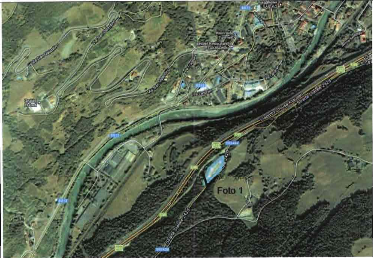
Vista aerea A.S.05
