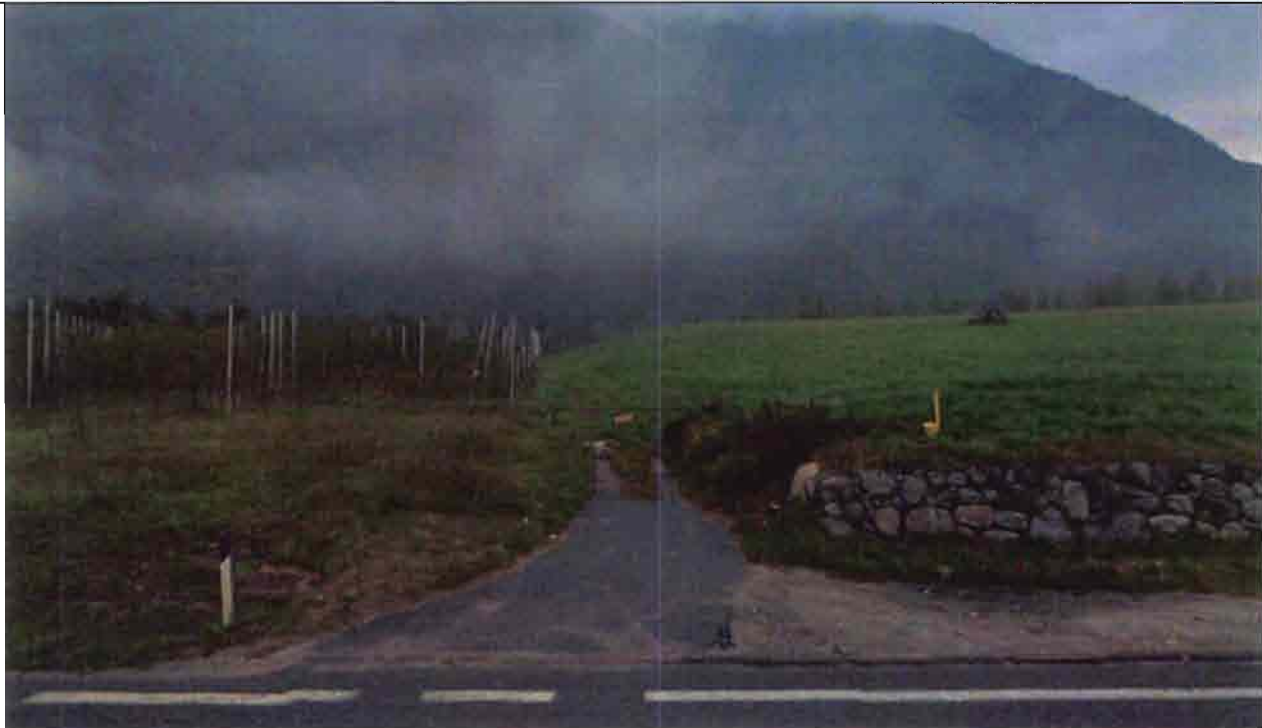
Accesso all'area di cantiere
