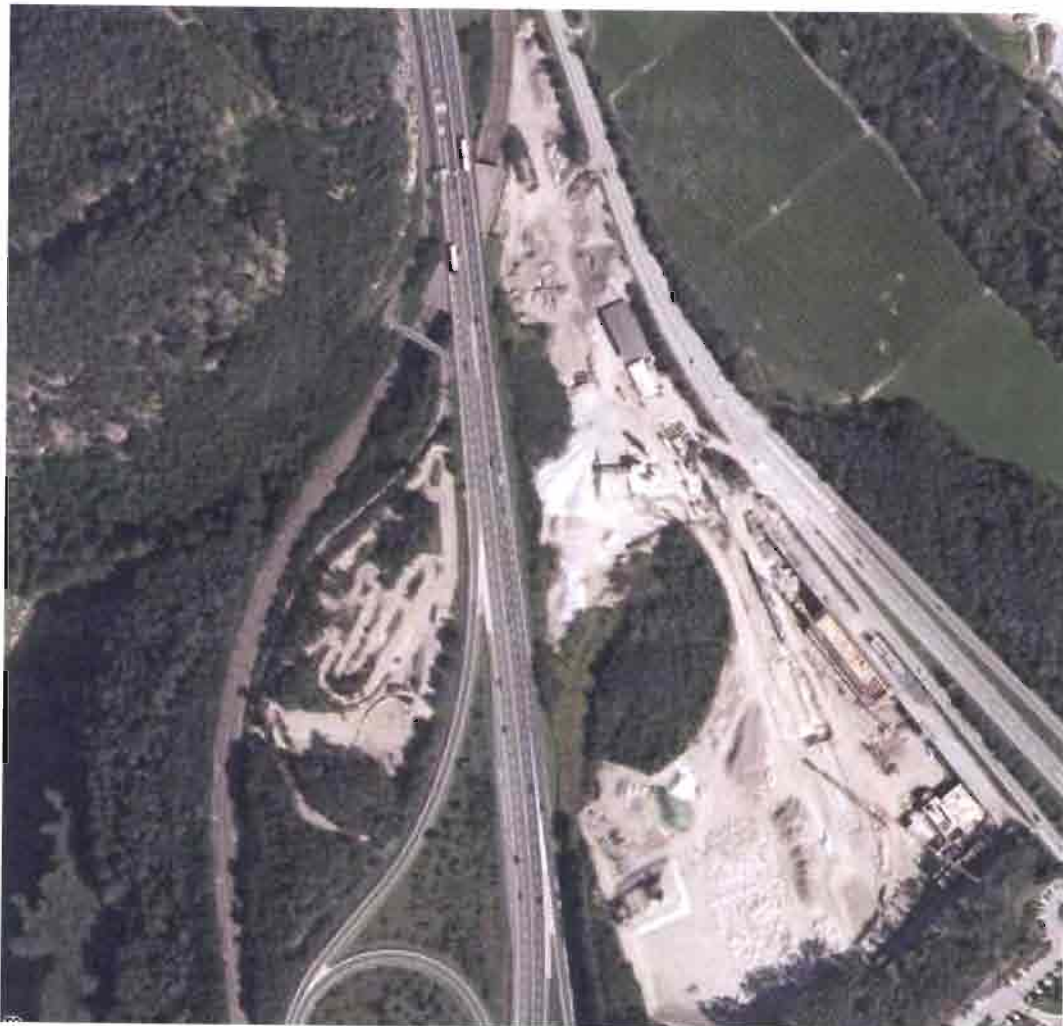
Figura 4: Cava Beton Gasser nel comune di Varna (BZ)
