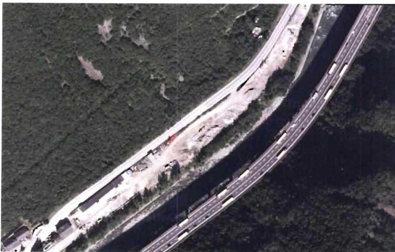
Figura 7: Impianto di recupero materiali da scavo dell'impresa Gregorbau nel comune di Fiè allo Scillar (BZ), in località Campodazzo – Zona Steg
