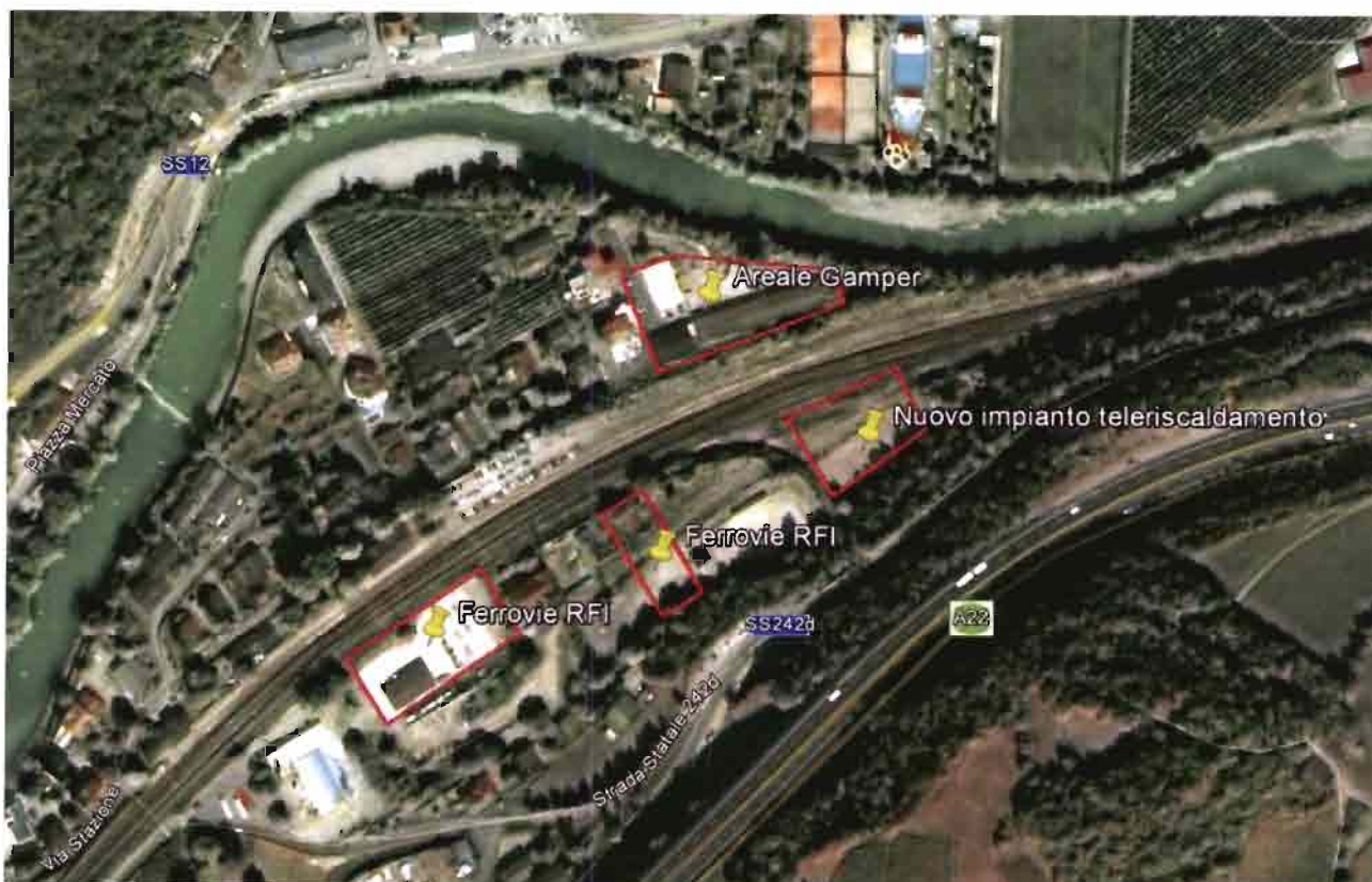
Figura 8-24: Ortofoto dell'ubicazione delle aree oggetto di bonifica in corrispondenza dell'impianto di teleriscaldamento di Chiusa
