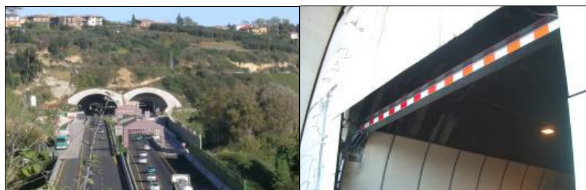
Fig. 6.3: Riduzione della gabarit e messa in opera della trave HEB180
