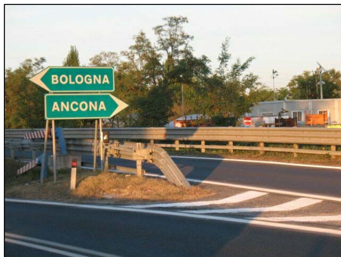
Sezione 8: Rampe sud del casello di Pesaro Urbino - entrata
