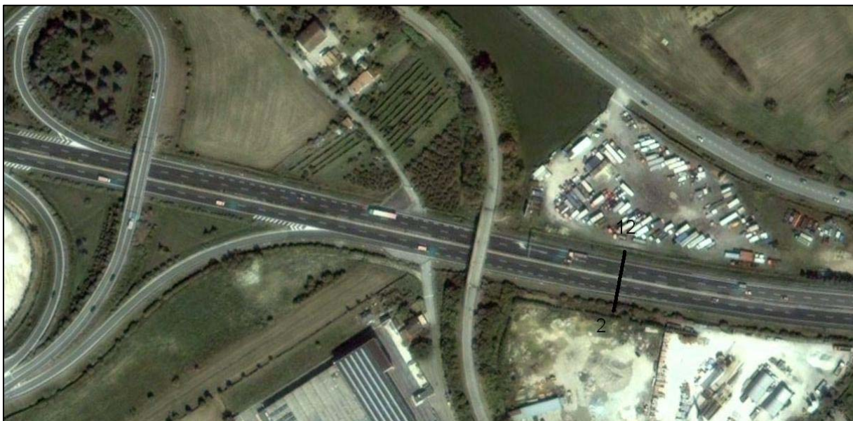
Sezioni 2 e 12: A14 tra i caselli di Cattolica-Gabicce e Pesaro Urbino
