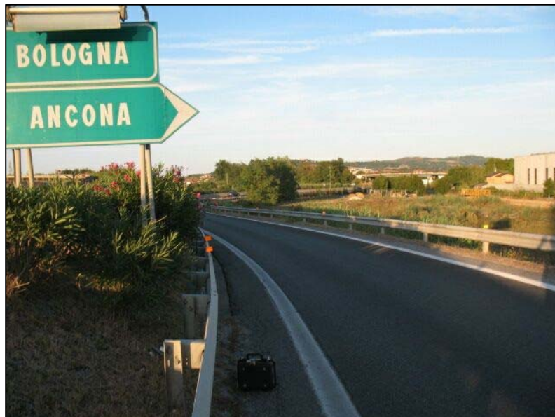
Sezione 6: Rampe sud del casello di Cattolica-Gabicce – entrata
