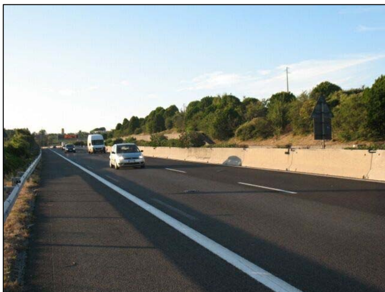
Sezione 11: A14 tra i caselli di Riccione e Cattolica-Gabicce direzione Nord
