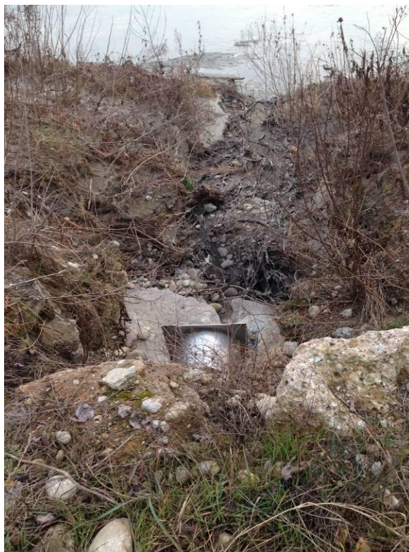
foto 2: scarico in Tanaro dello sfiatore del SIS1
