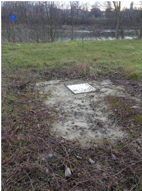
foto 4: pozzetto esistente del SISI
