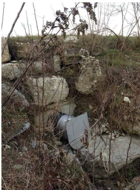
foto 3: particolare dello sfiatore del SIS1 dotato di valvola antiriflusso.
