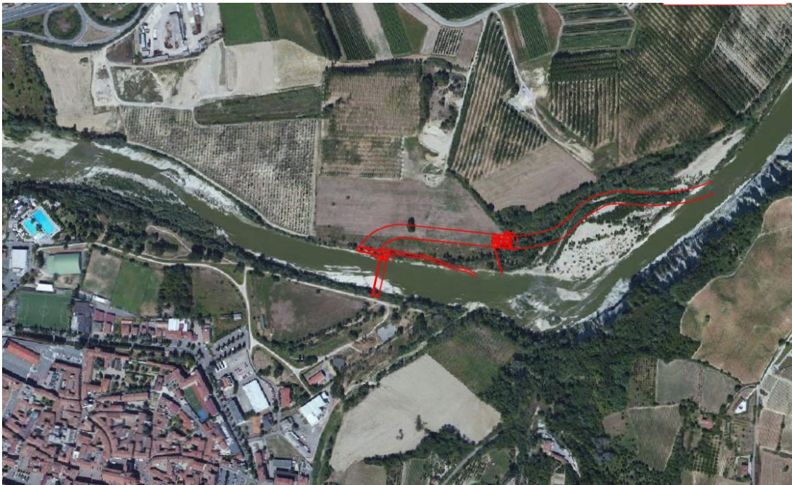
Fig. 8.2: Fotografia aerea con localizzazione dell'impianto in progetto.
