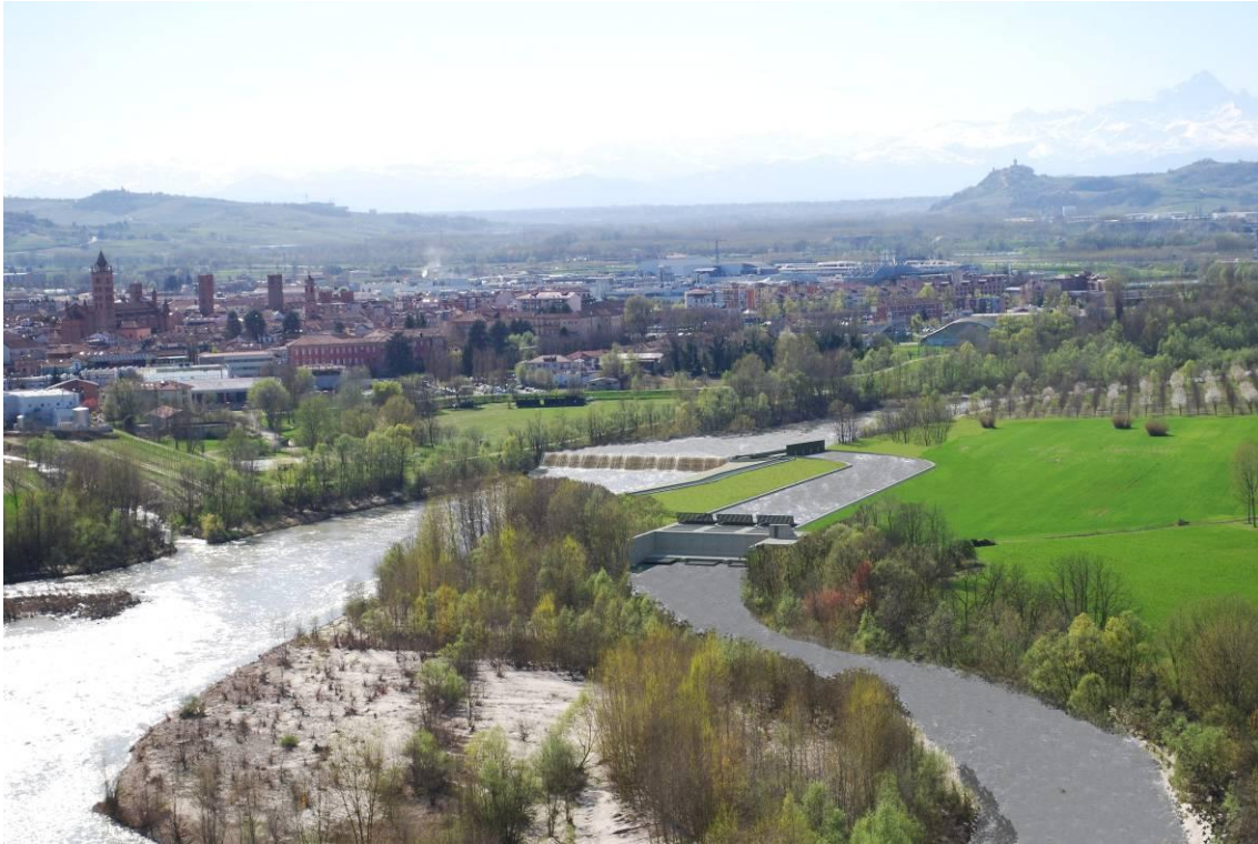
Fotoinserimento 1: vista panoramica dell'impianto in progetto
