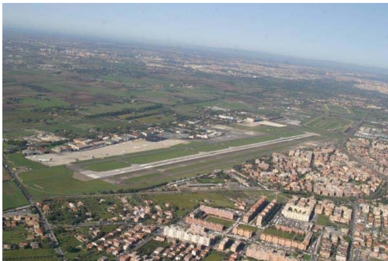
FIGURA 1.1 VISTA DALL'ALTO DELL'AEROPORTO DI CIAMPINO
