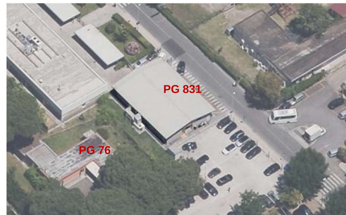
FIGURA 4.23 - ATTUALE EDIFICIO RENT A CAR PG 831A
