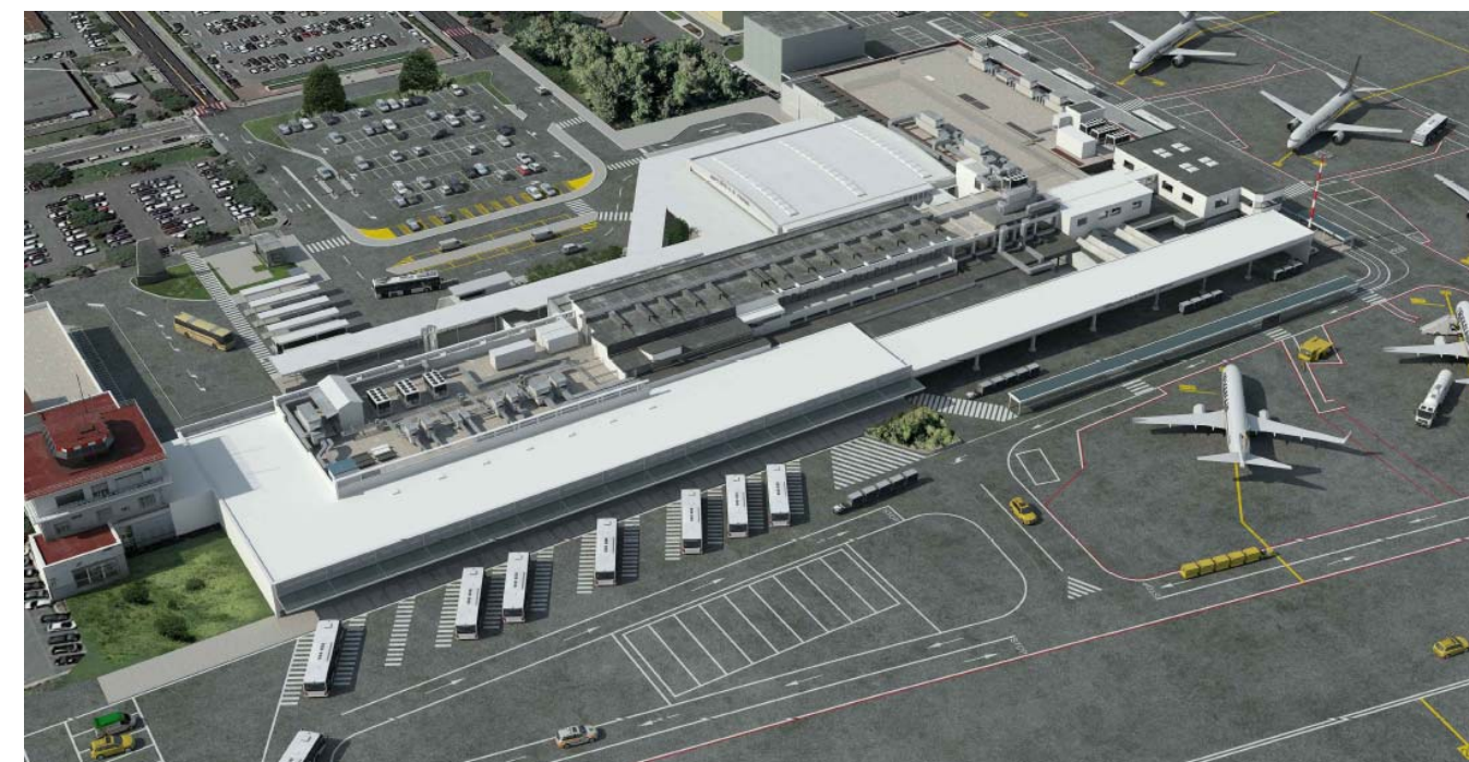
FIGURA 4.3 - TERMINAL AVIAZIONE COMMERCIALE. SIMULAZIONE AEREA DA EST
