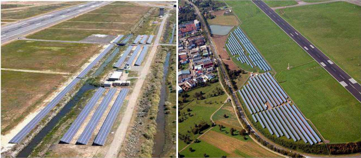
Figure 4.5 Esempi di impianti fotovoltaici in ambito aeroportuale.
