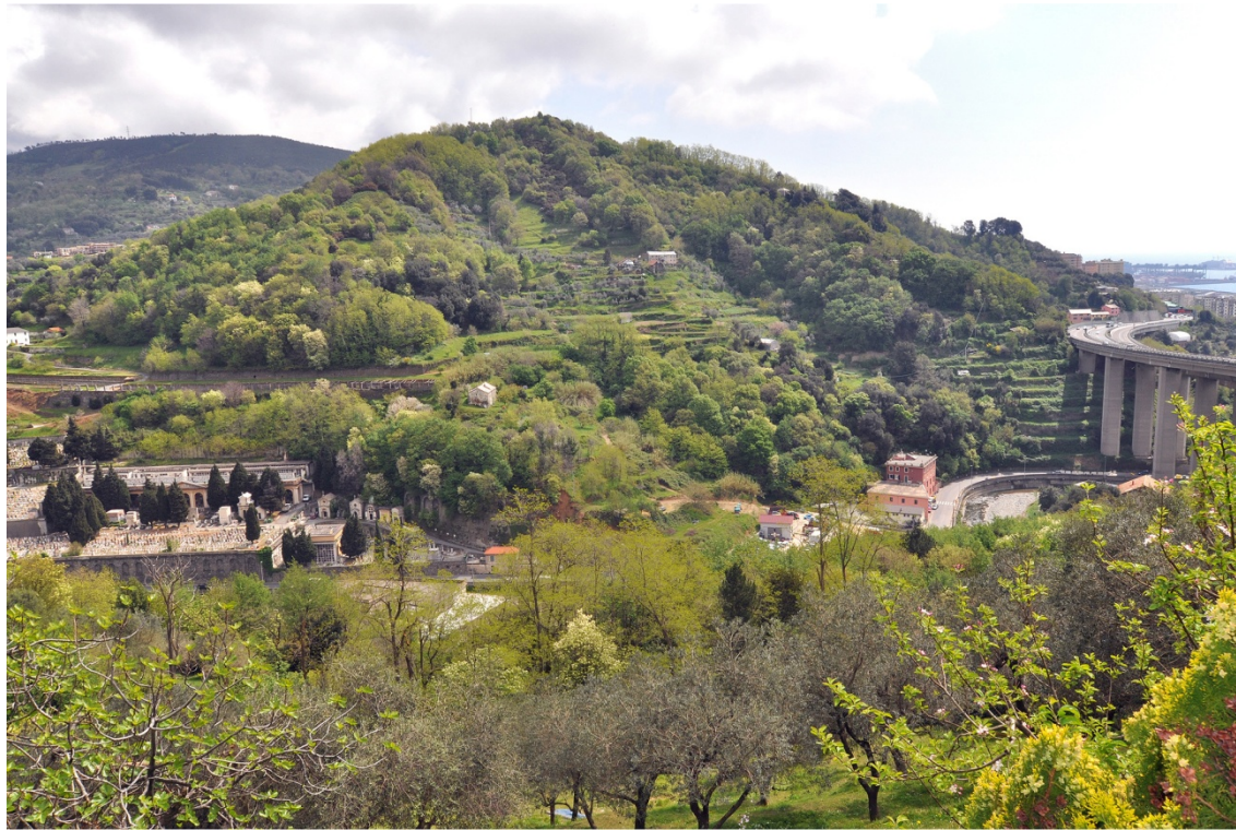
Figura 13 – Imbocco Amandola lato SV – Ante operam
