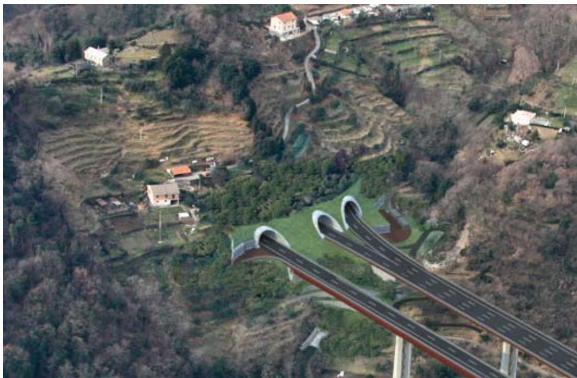
Figura 2-3 – Imbocco Voltri lato GE - Fotoinserimento variante progettuale
