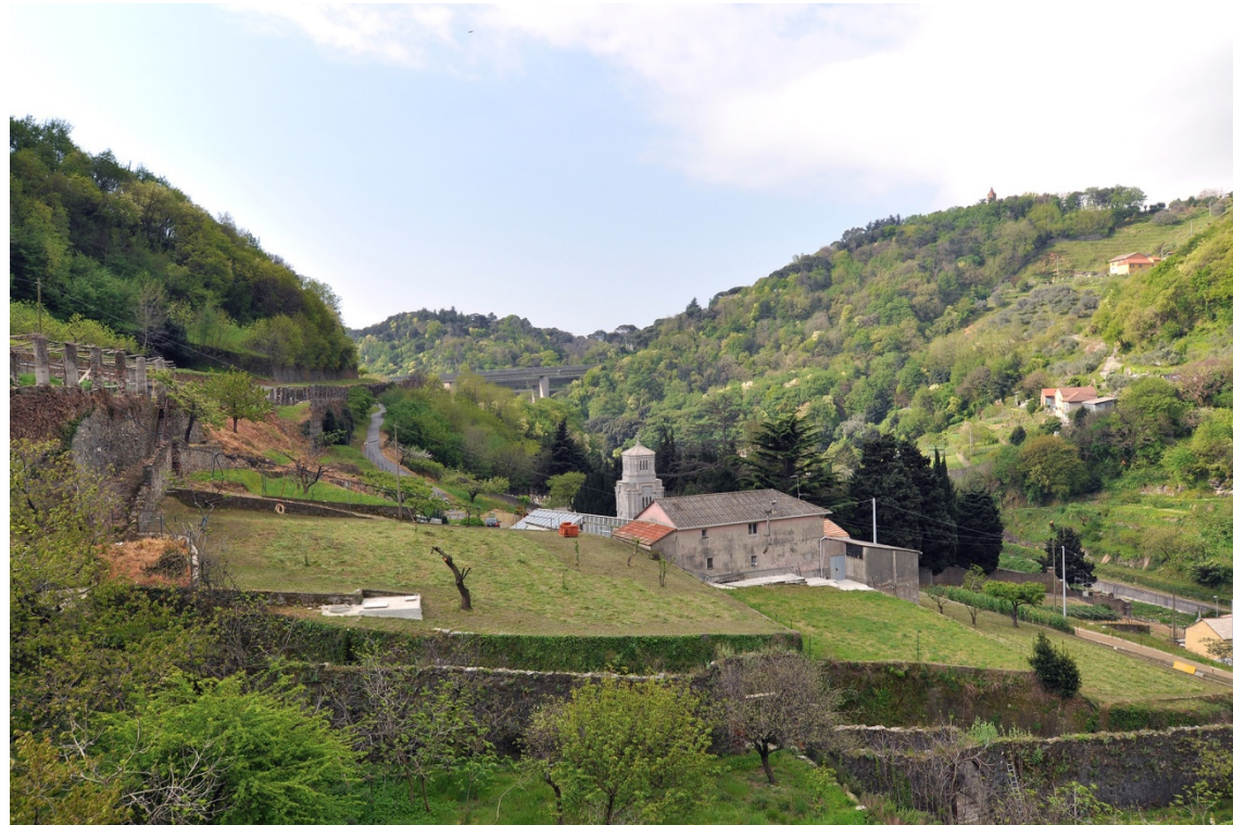
Figura 17 – Viadotti Leiro – Ante operam
