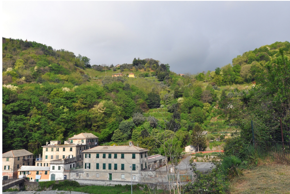
Figura 9 – Imbocco Voltri lato GE – Ante operam
