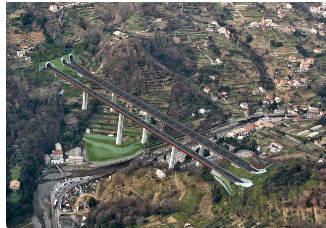
Figura 4 - Viadotti Voltri, imbocchi connessi e cantiere pile - Fotoinserimento - Settembre 2015
