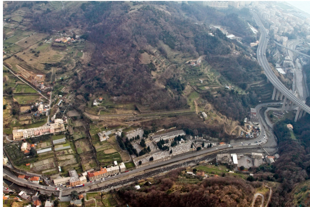
Figura 5 - Viadotti Voltri e imbocchi connessi - Ante operam
