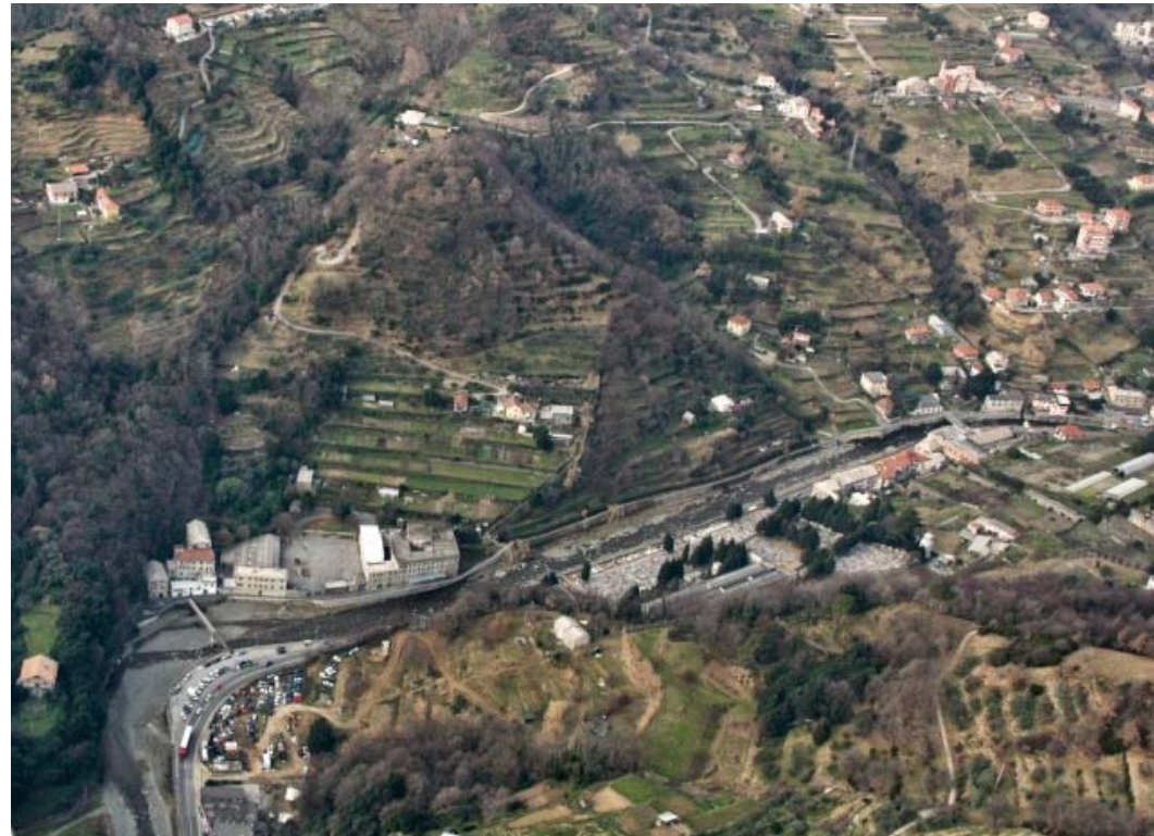
Figura 1 - Viadotti Voltri e imbocchi connessi - Ante operam
