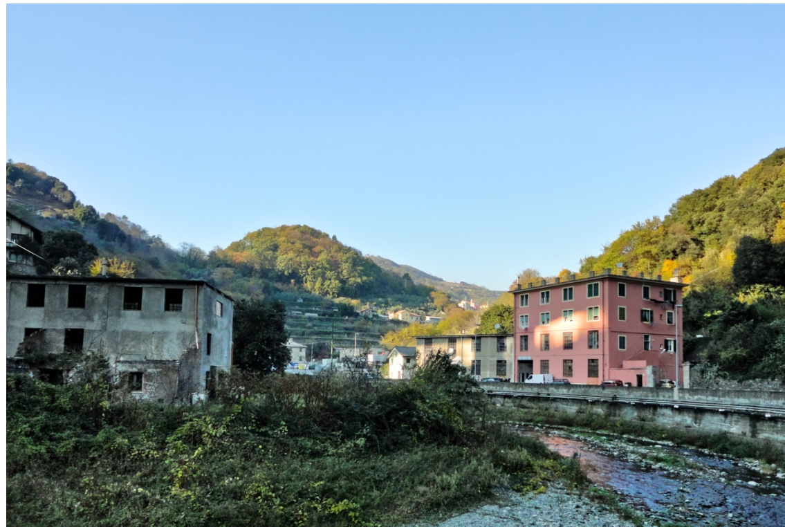
Figura 21 – Viadotti Leiro – Ante operam
