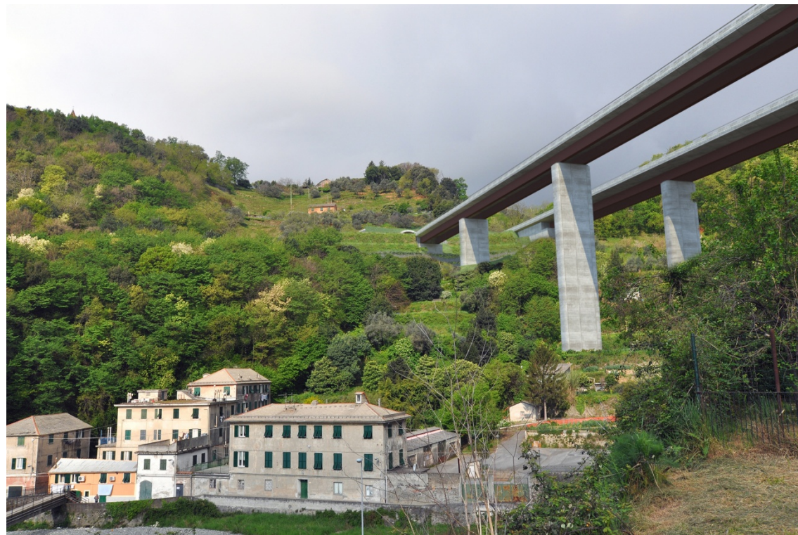
Figura 10 – Imbocco Voltri lato GE - Fotoinserimento – Giugno 2015
