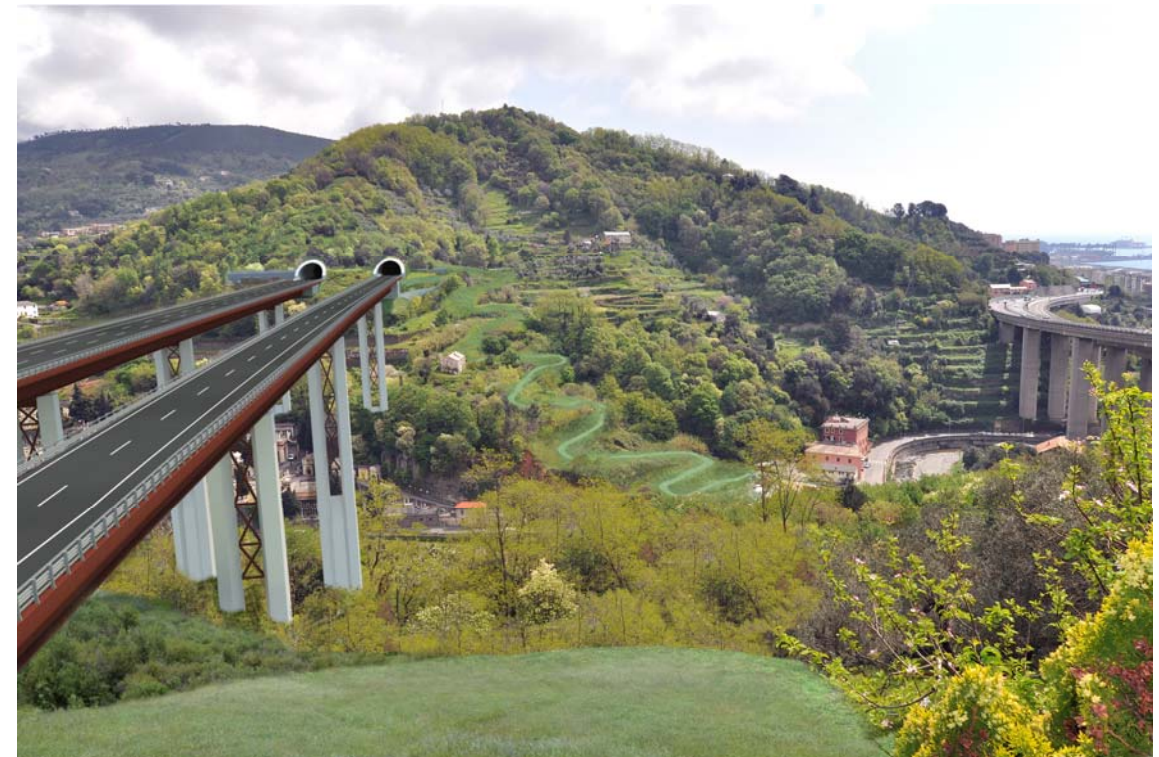
Figura 16 – Imbocco Amandola lato SV e VS.06 - Fotoinserimento – Settembre 2015
