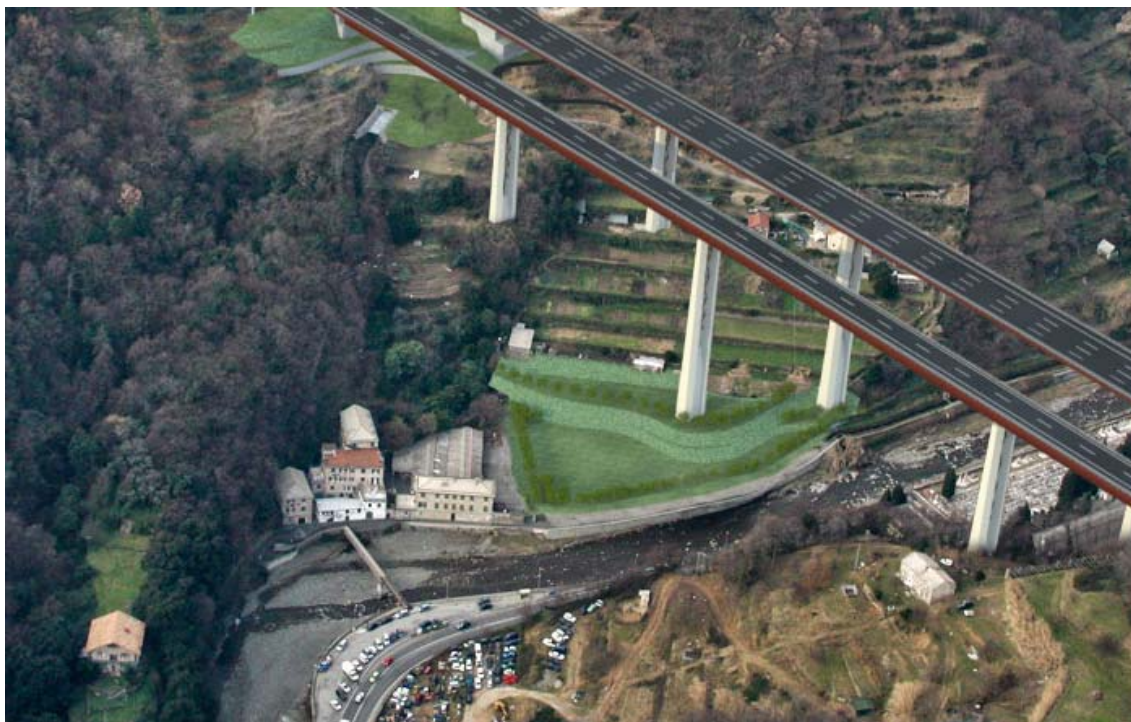
Figura 2-7 – Sistemazione definitiva cantiere pile viadotti Leiro - Fotoinserimento
