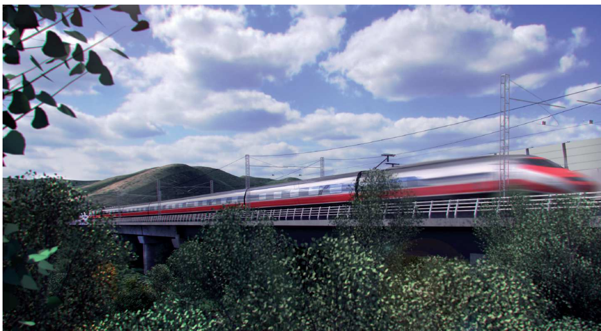
Fig. 7 – VI07 Viadotto Isclero
