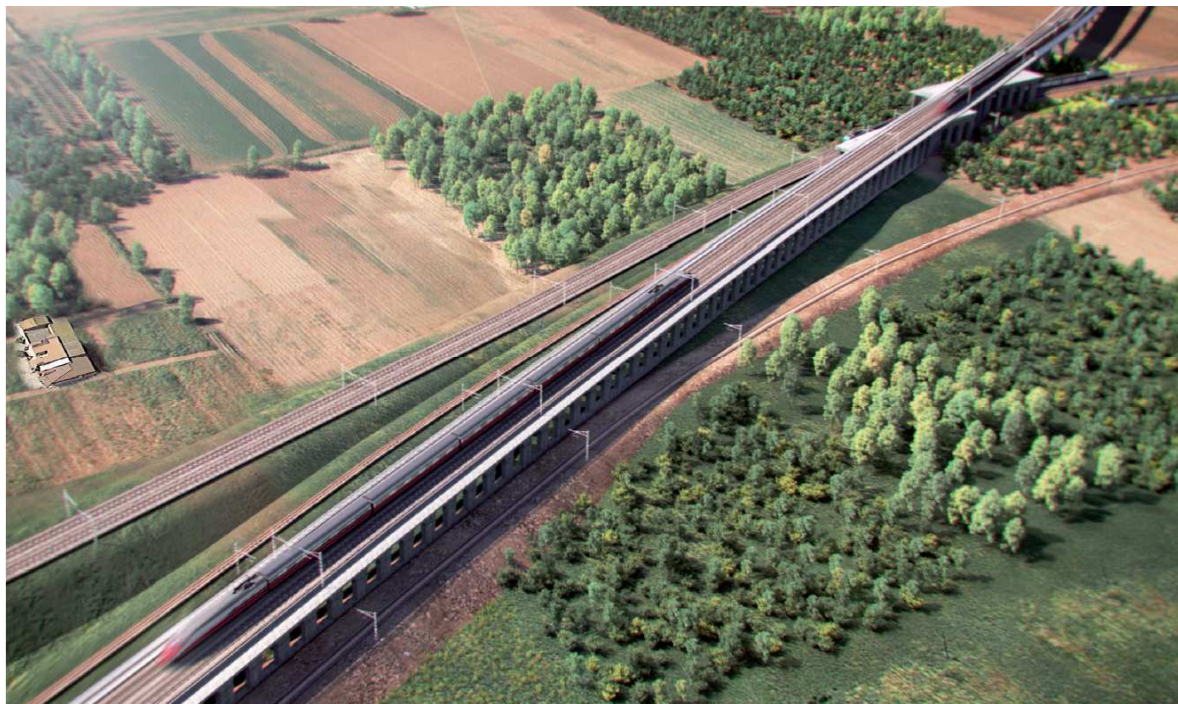
Fig. 8 – Struttura ad Archi – collegamento scalo Marcianise
