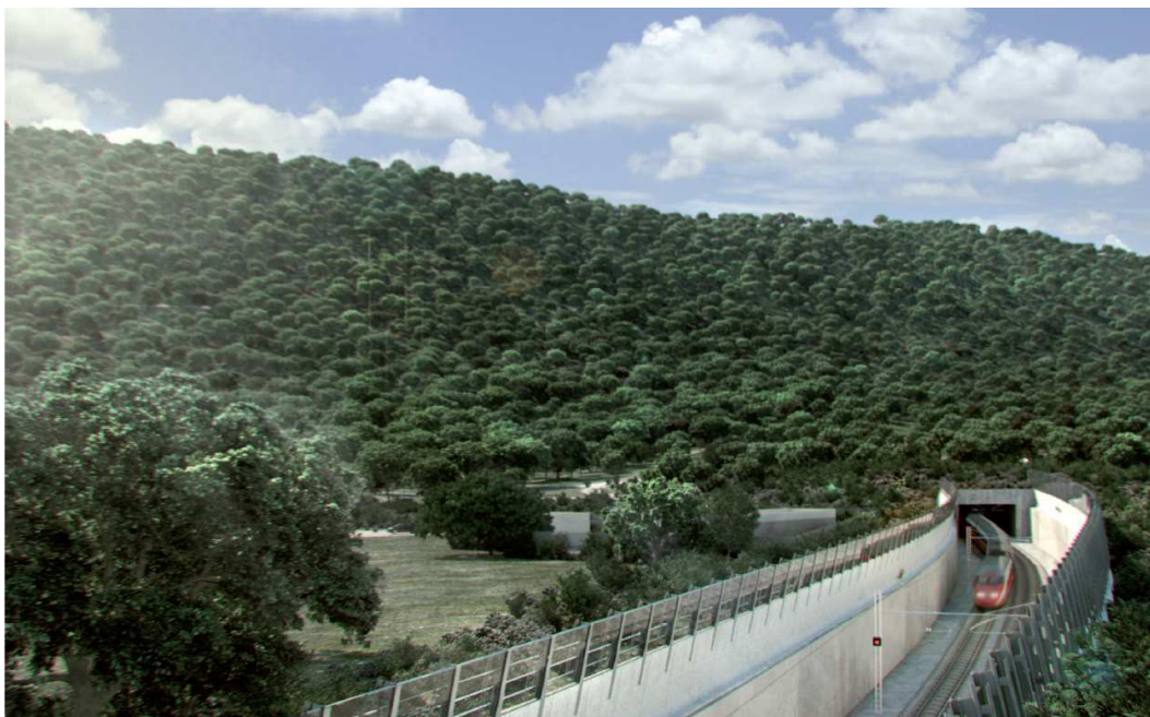
Fig. 5 – Imbocco Nord della Galleria Monte Aglio
