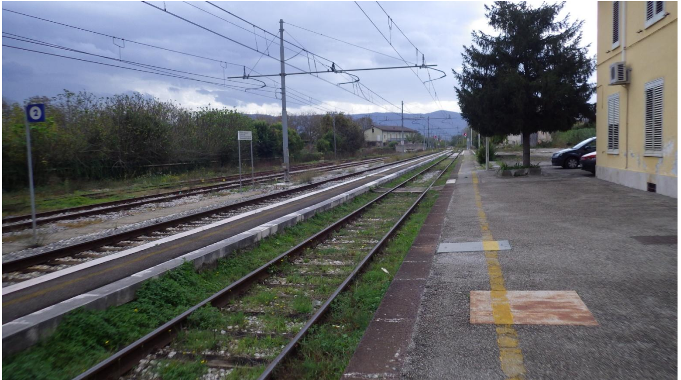
Figura 44- Vista panoramica della stazione di Frasso Telesino.
