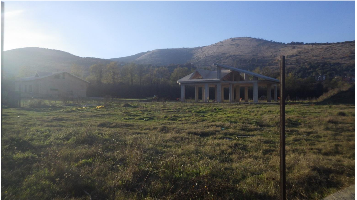
Figura 43 – Vista panoramica del versante dove è previsto l’imbocco Nord della galleria in esame.
