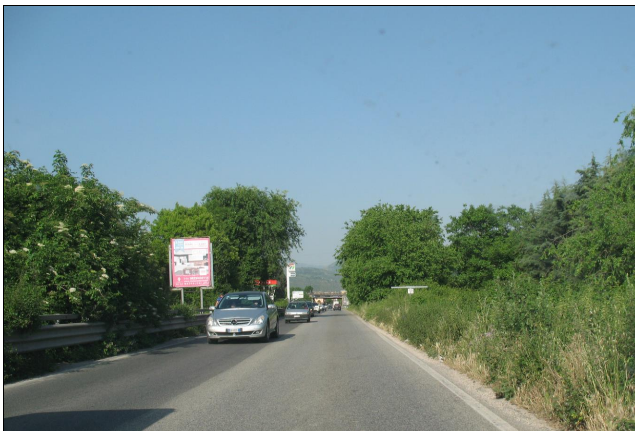
Figura 15 – Stato dei luoghi: zona realizzazione Ponte Via Napoli_VI11
