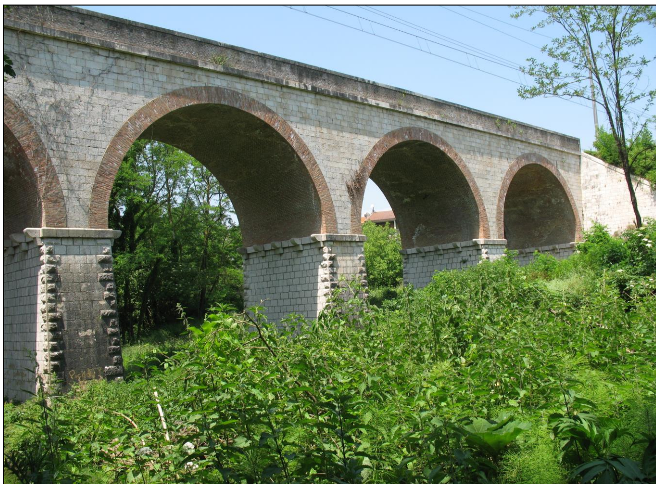
Figura 60 – Ponte esistente sul Torrente S. Giorgio, vista da monte verso valle
