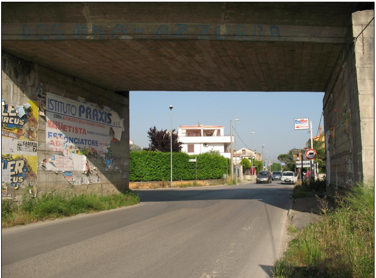
Figura 27 – Stato dei luoghi: zona realizzazione Ponte Via Appia_VI16, con vista in primo piano del ponte stradale esistente della Tangenziale Maddaloni S.S 700
