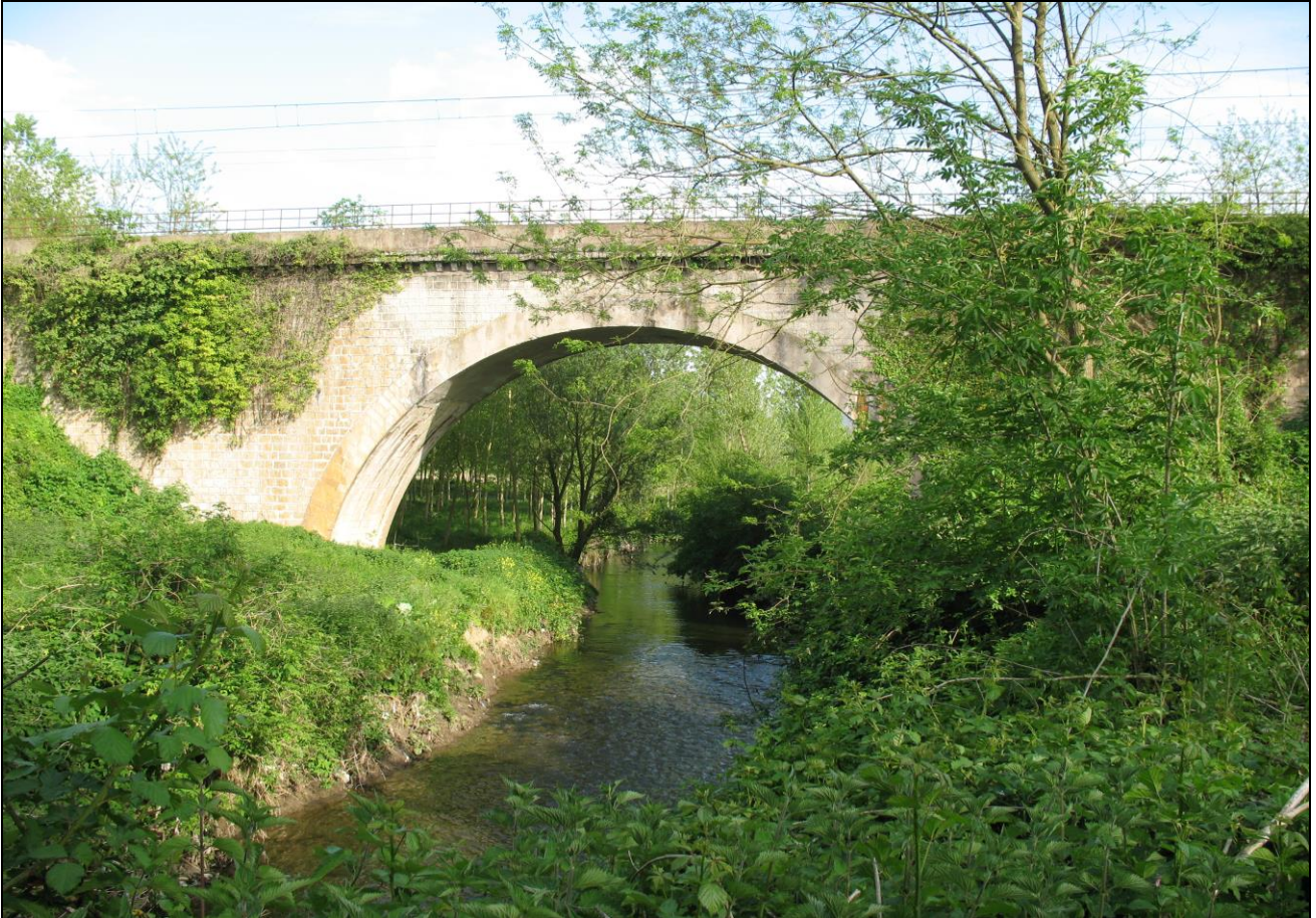
Figura 52 – Ponte esistente sul Torrente Isclero, vista da valle verso monte
