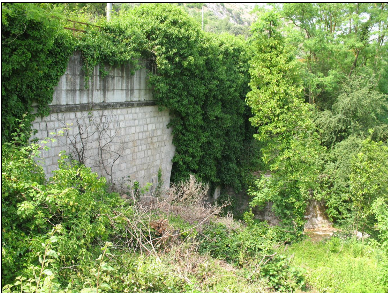
Figura 37 – Ponte esistente sul Rio Secco, vista da valle verso monte
