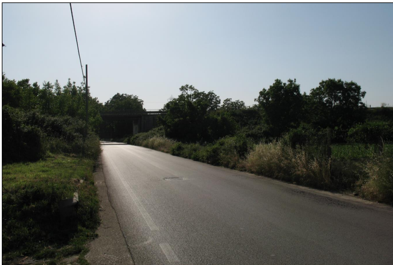
Figura 25 – Stato dei luoghi: zona realizzazione Ponte Via Cornato_VI15, con vista sullo sfondo del ponte stradale esistente della Tangenziale Maddaloni S.S. 700
