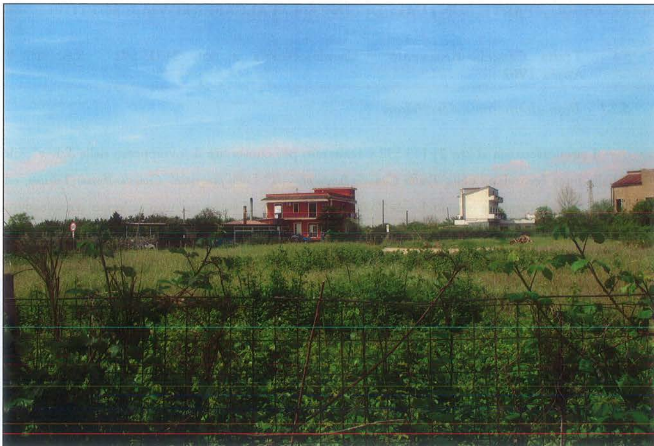
Figura 2 – Stato dei luoghi: zona realizzazione Cavalcaferrovia al km 2+113.592 - S.S. n°7_Via Appia_IV02
