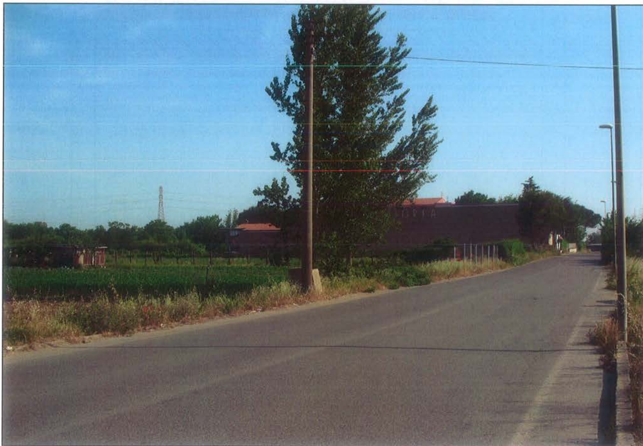
Figura 21 – Stato dei luoghi: zona realizzazione Sottovia al km 4+311.773 - Via Ficucella_SL03
