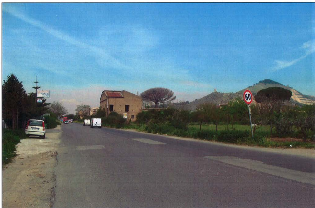
Figura 1 – Stato dei luoghi: zona realizzazione Cavalcaferrovia al km 2+113.592 - S.S. n°7_Via Appia_IV02
