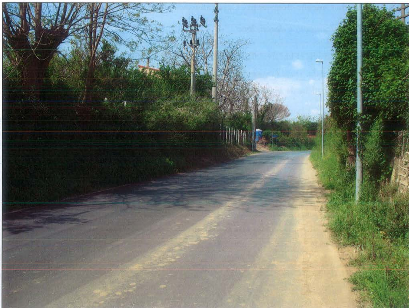
Figura 7 – Stato dei luoghi: zona realizzazione Cavalcaferrovia al km 2+220.334 - Via Carmignana_IV03
