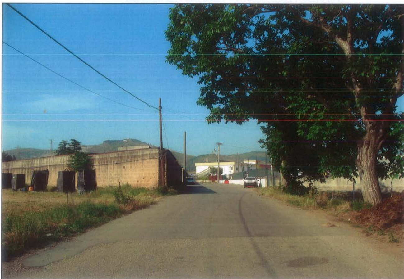
Figura 24 – Stato dei luoghi: zona realizzazione sottovia al km 5+087.287_SL04
