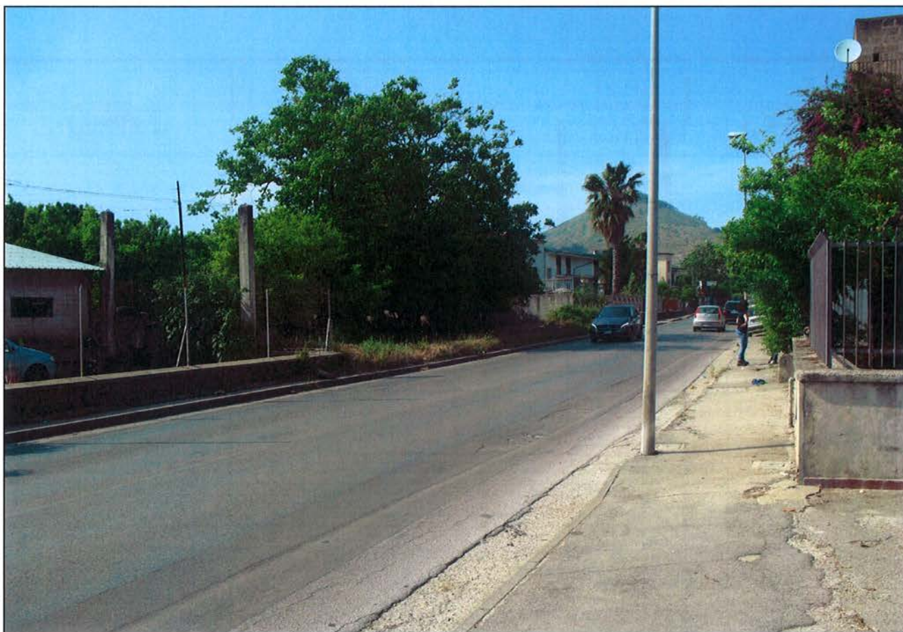
Figura 15 – Stato dei luoghi: zona realizzazione Sottovia al km 2+747.708_S.P. n°7 - Via Canello_SL01
