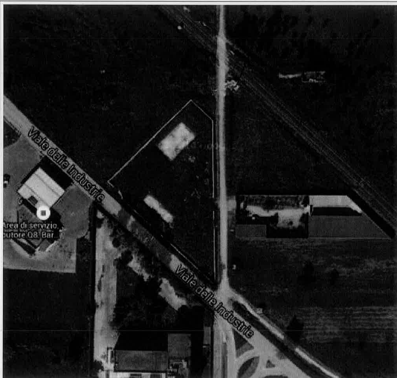
Vista aerea della struttura in c.a. presente nell'area.
