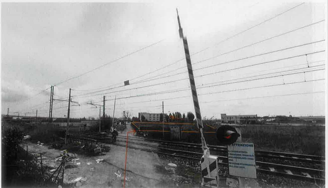
Foto 4 - Viabilità di accesso al CB1L3 vista dal lato del P.L..
