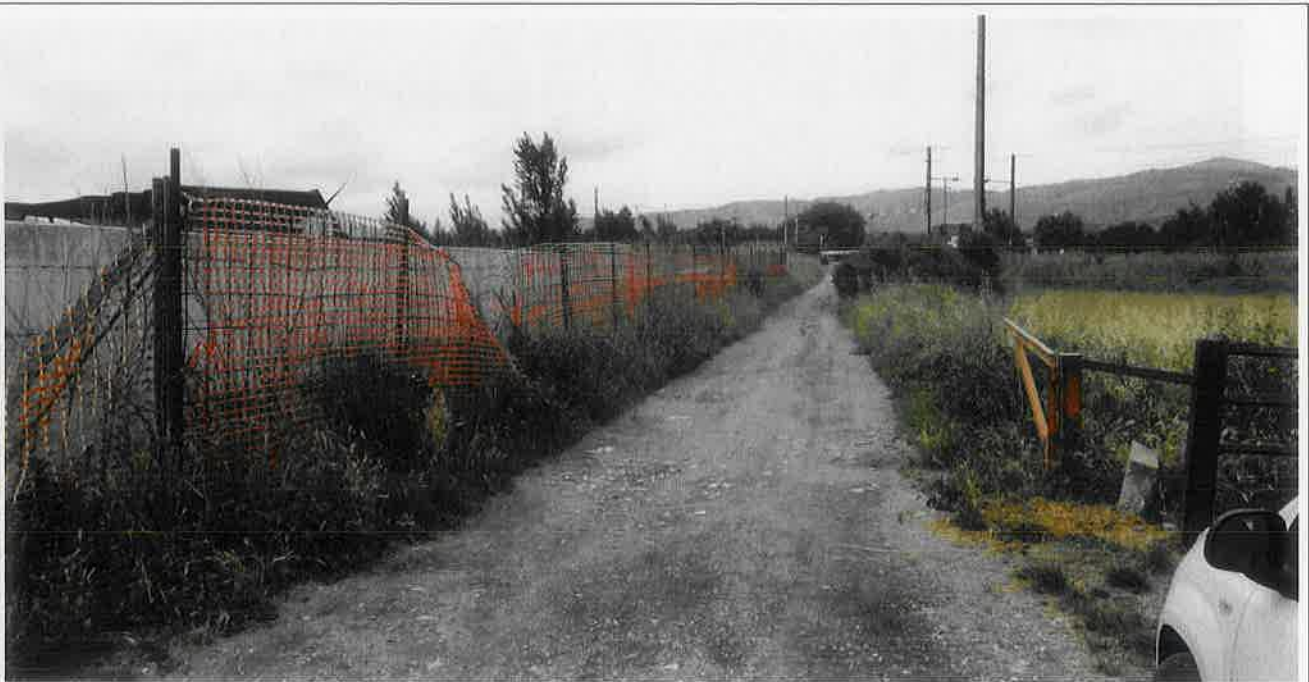
Foto 3 - Viabilità di accesso al CB1L3 da Viale delle Industrie.
