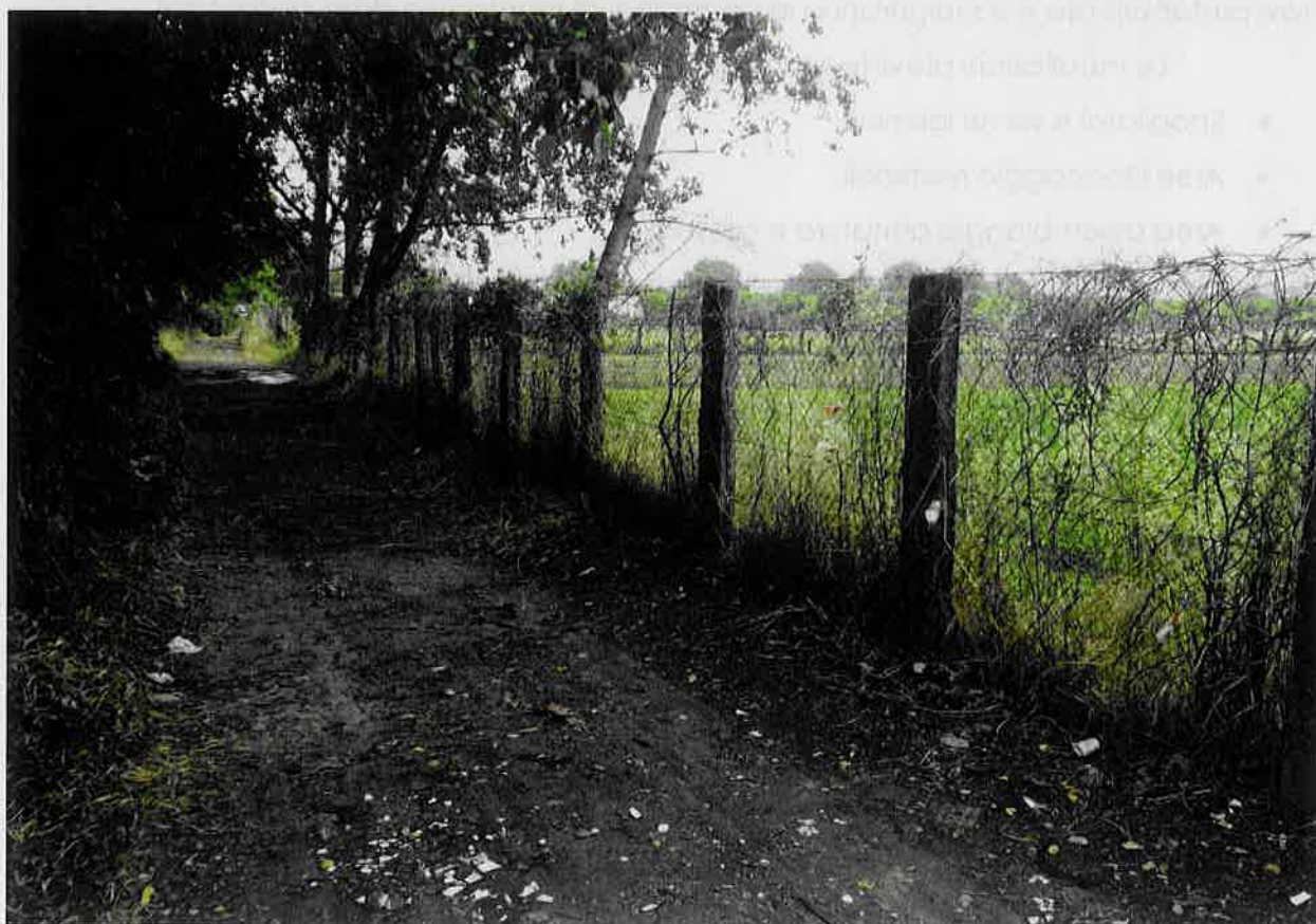
Foto 3 - Viabilità di accesso "Via Baldina": la stradina interpoderal è di ridotte dimensioni.
