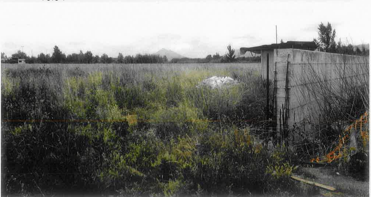
Foto 2 - Presenza nell'area di muro in c.a..
