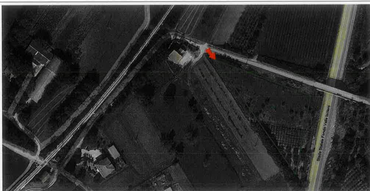
Vista aerea dell'area tecnica AT.4.L1.
