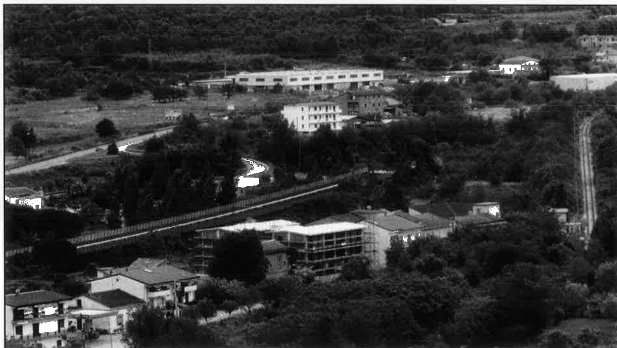
Figura 4-40 - Foto dal punto di vista individuato per il fotoinserimento dall'abitato di Valle di Maddaloni: situazione post operam
