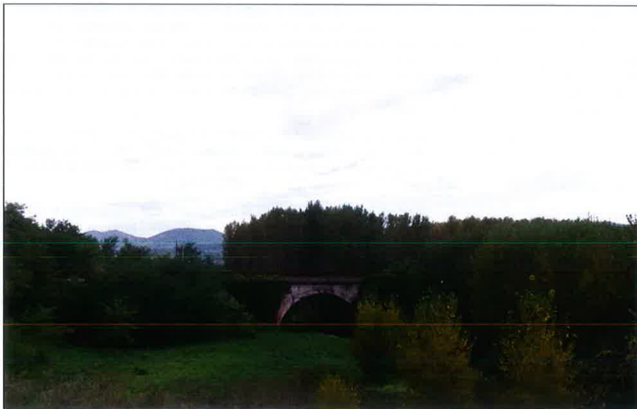
Figura 4-10 – Vegetazione in prossimità dell'attuale viadotto sul fiume Isclero
