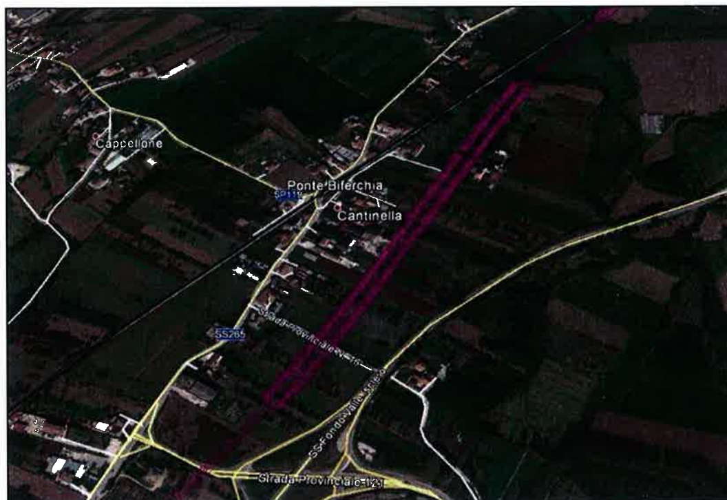
Figura 4-22 - Tratto in rilevato ad est di Cantinella
