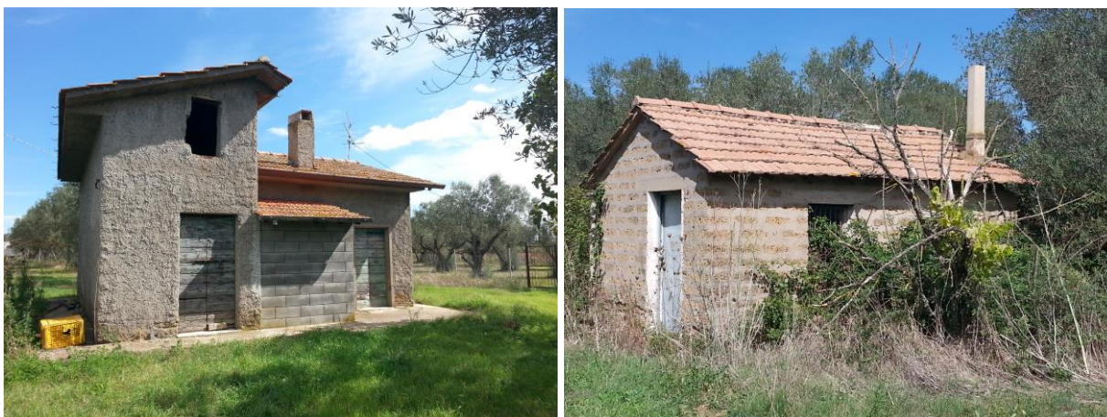
Figura 4.19-2: I due manufatti interferiti nei pressi dello svincolo Cinelli
