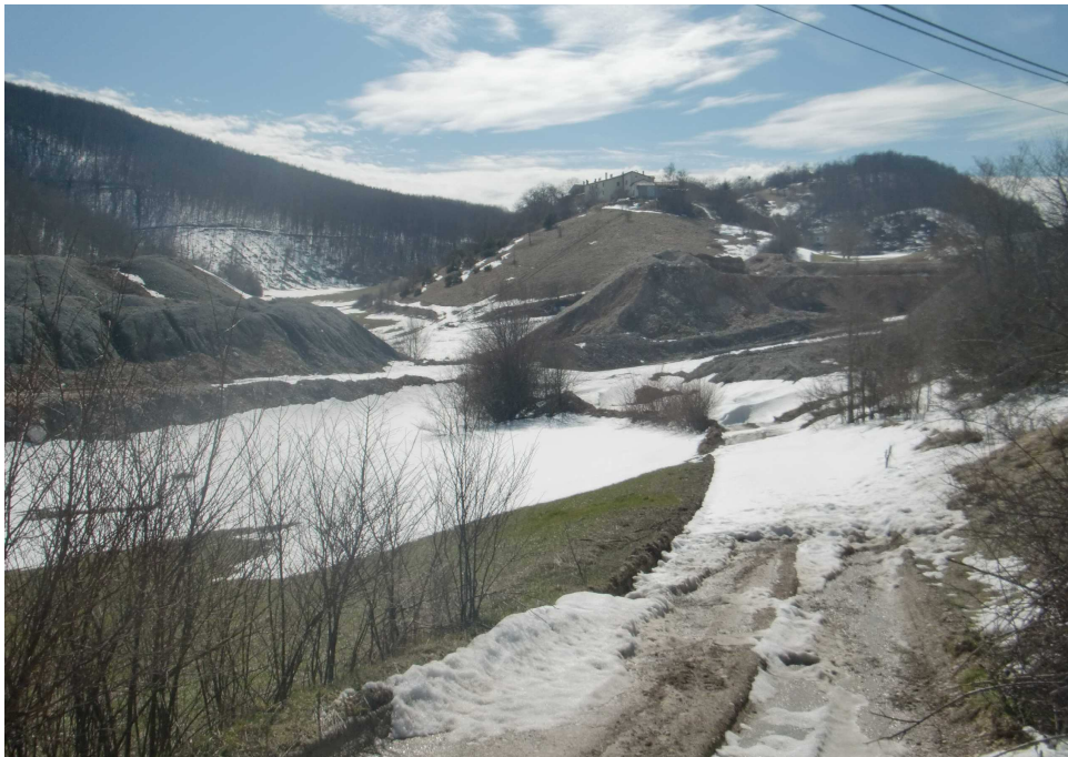
Figura 7.a - Immagine dell'area in fase di cantiere
