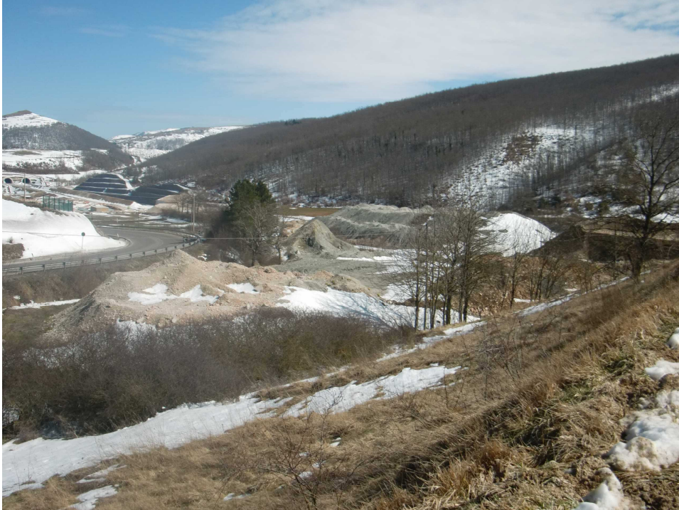
Figura 7.d - Immagine dell'area in fase di cantiere
