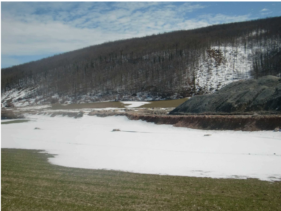
Figura 7.c - Immagine dell'area in fase di cantiere
