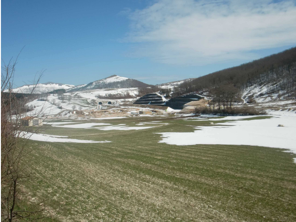
Figura 7.b - Immagine dell'area in fase di cantiere
