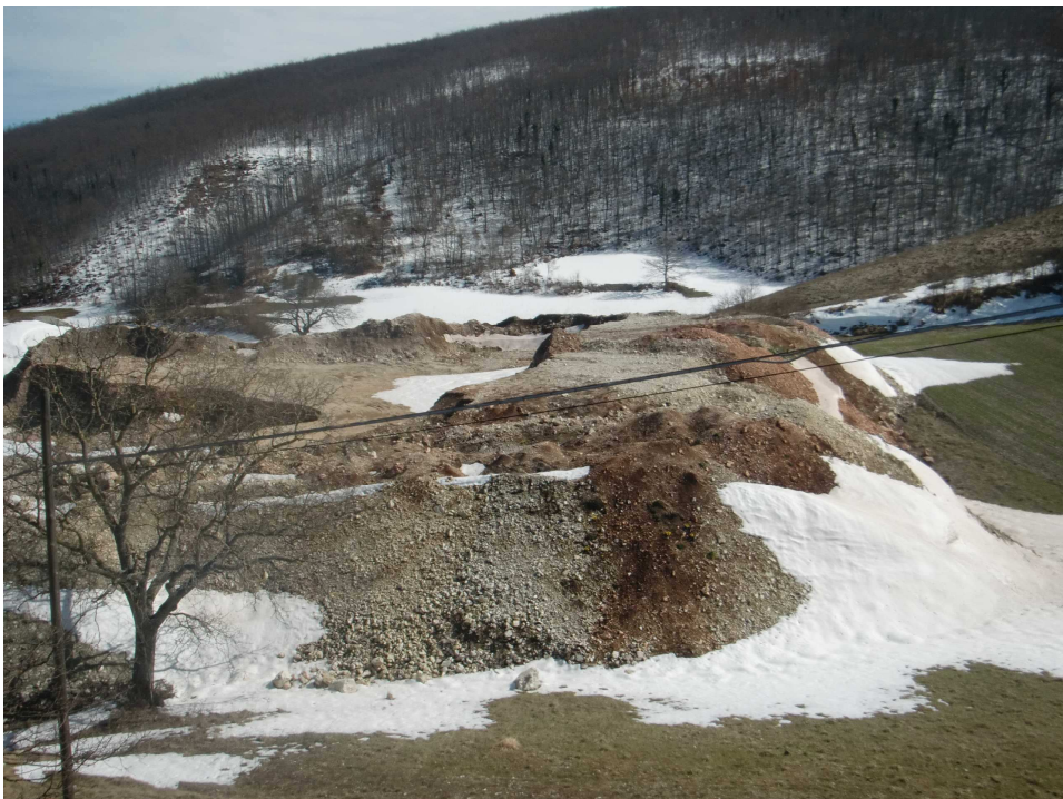
Figura 7.e - Immagine dell'area in fase di cantiere
