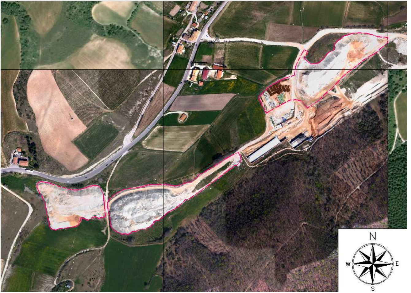
Figura 2 - Ortofoto d'inquadramento dell'area "ST3" stato attuale.
