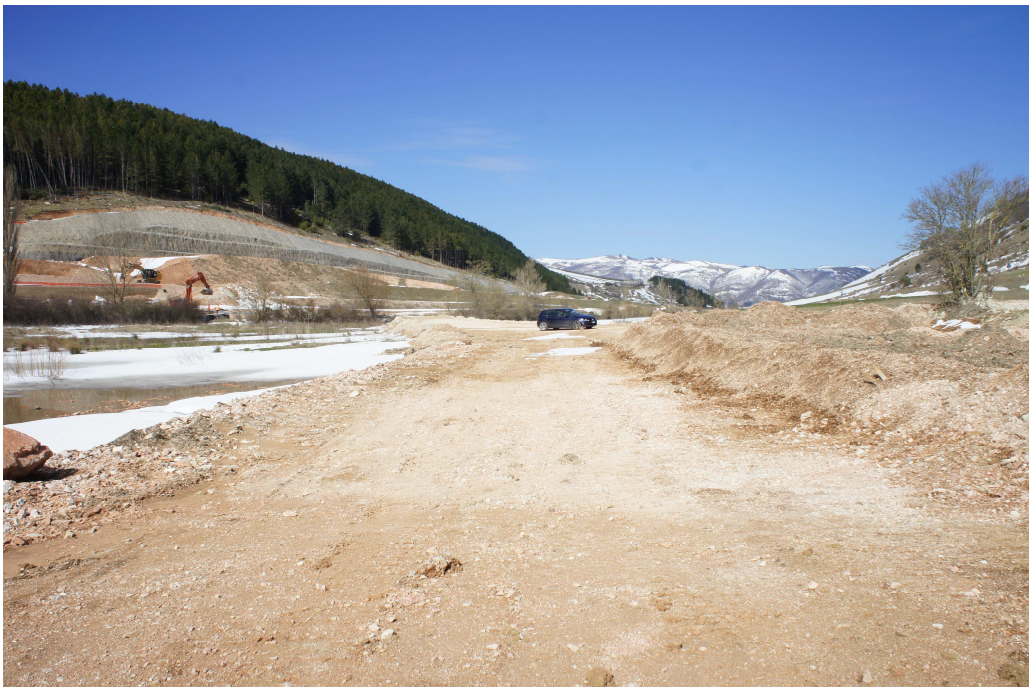
Figura 6.b - Immagine dell'area in fase di cantiere
