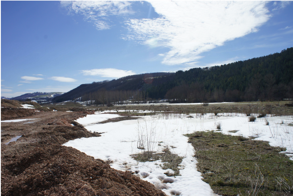
Figura 6.a - Immagine dell'area in fase di cantiere
