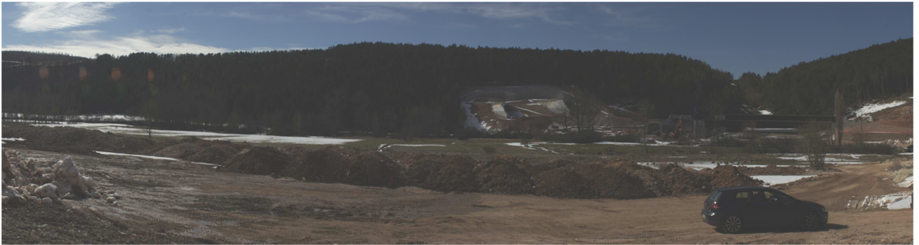
Figura 6.c - Immagine dell'area in fase di cantiere
