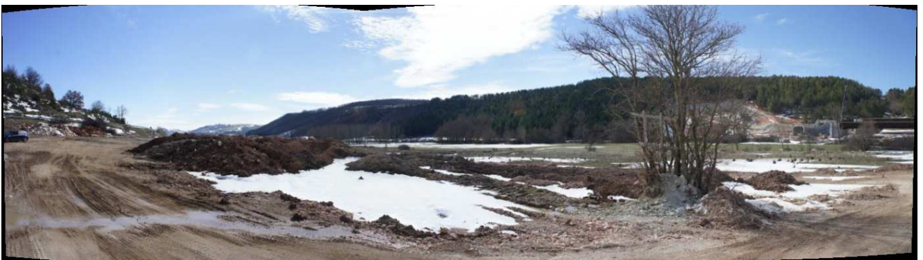
Figura 6.d - Immagine dell'area in fase di cantiere
