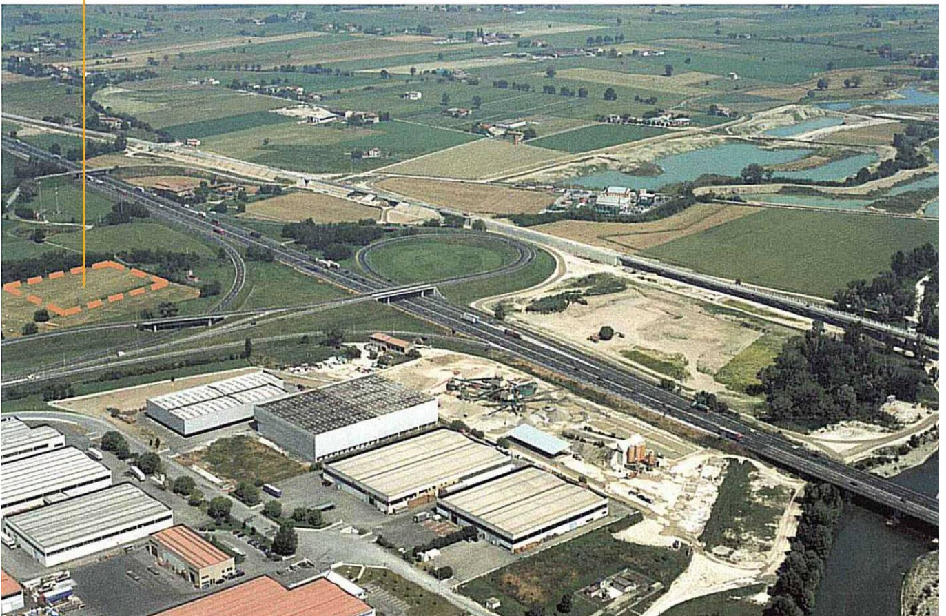
Figura 6.30 – Foto aerea con individuazione dell'area di cantiere 1A stralciato dal Progetto Esecutivo (tratteggio arancione).
