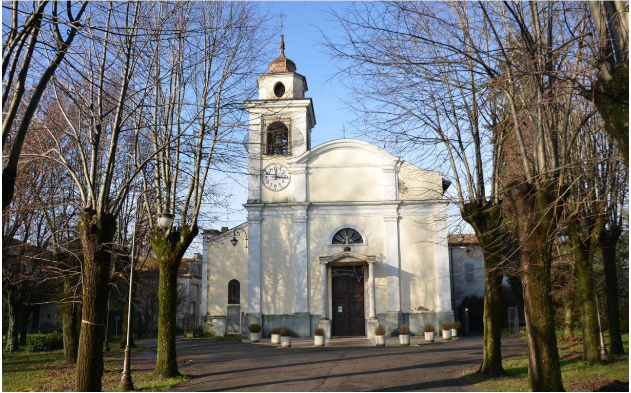
Figura 4.2 – Chiesa parrocchiale di S. Giorgio in località Viarolo.
