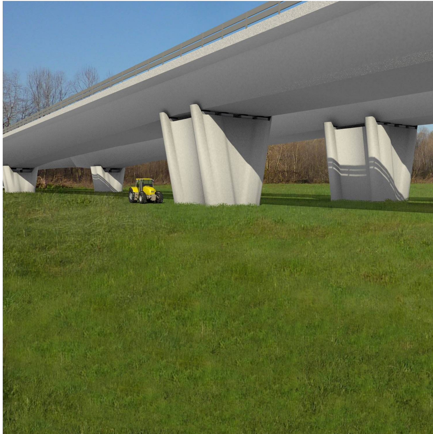
Progetto Definitivo , Pila P11 della Carreggiata Nord e Pila P11 della Carreggiata Sud.
