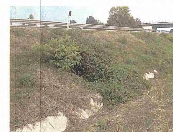
MANUFATTO 2 - LATO OVEST (M02)
