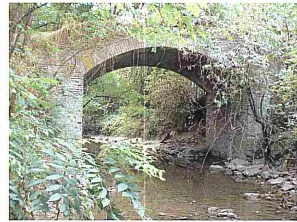
MANUFATTO 5 - LATO NORD (M05)
