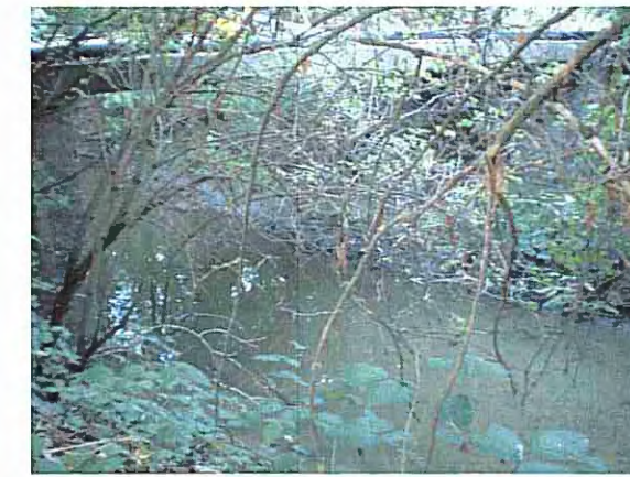
MANUFATTO 6 - LATO SUD (M06)
