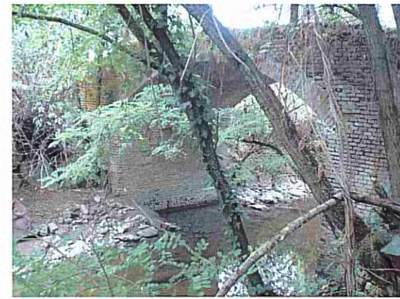
MANUFATTO 5 - LATO SUD (M05)
