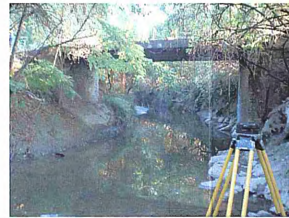
MANUFATTO 6 - LATO NORD (M06)
