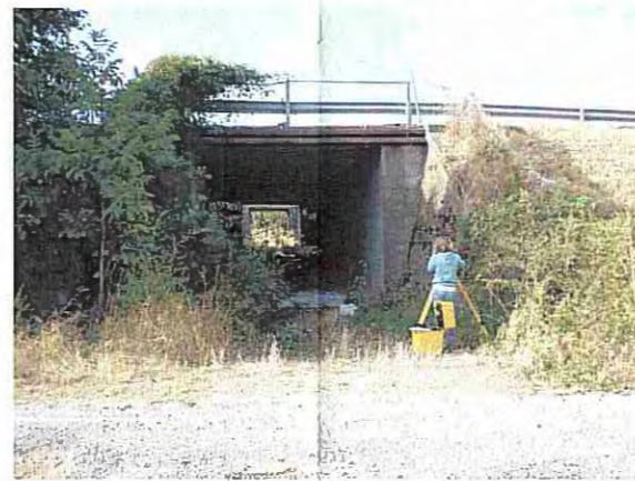
MANUFATTO 9 - LATO NORD (M09)
