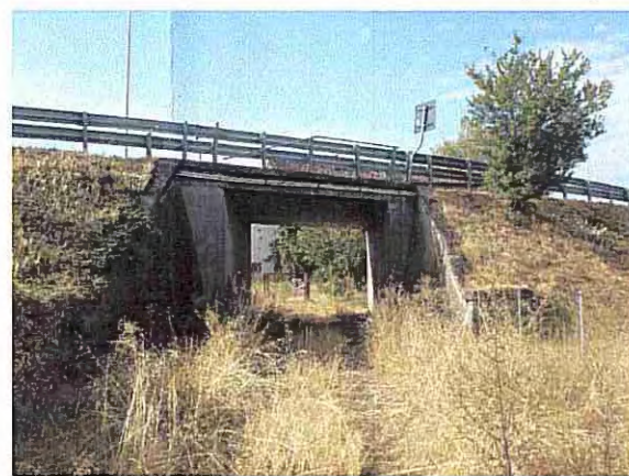
MANUFATTO 8 - LATO NORD (M08)
