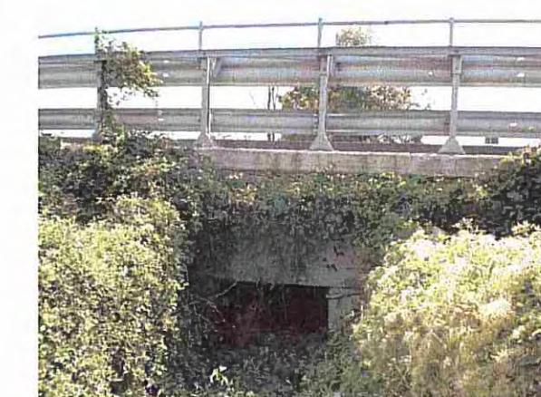
MANUFATTO 13 - LATO NORD (M13)
