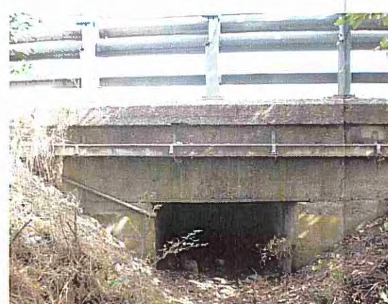
MANUFATTO 13 - LATO SUD (M13)
