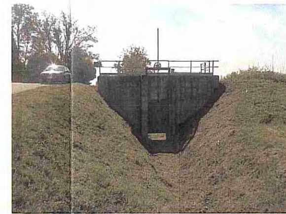
MANUFATTO 21 - LATO NORD (M21)
