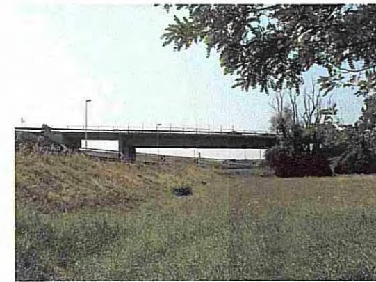
MANUFATTO M24 - LATO NORD
