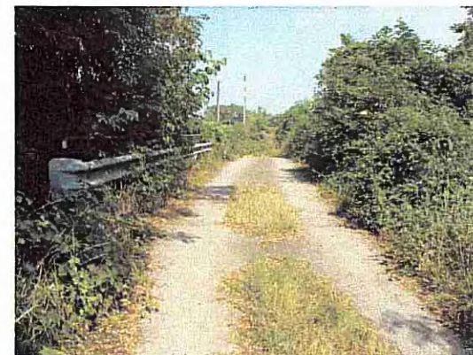
MANUFATTO M23 - LATO EST
