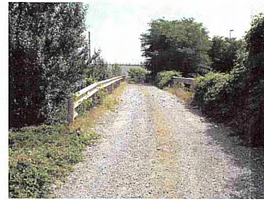
MANUFATTO M25 - LATO OVEST
