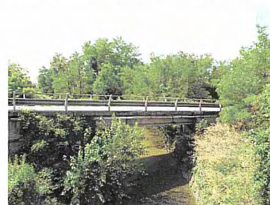
MANUFATTO M26 - LATO NORD
