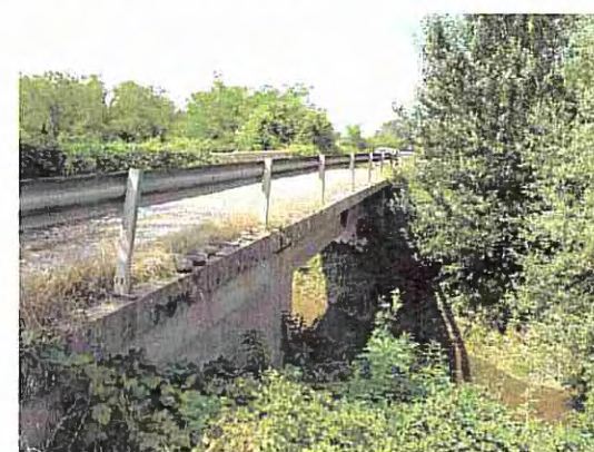
MANUFATTO M25 - LATO NORD
