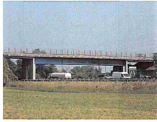
MANUFATTO M35 - PROSPETTO OVEST
