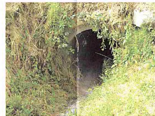
MANUFATTO M36 - LATO SUD
