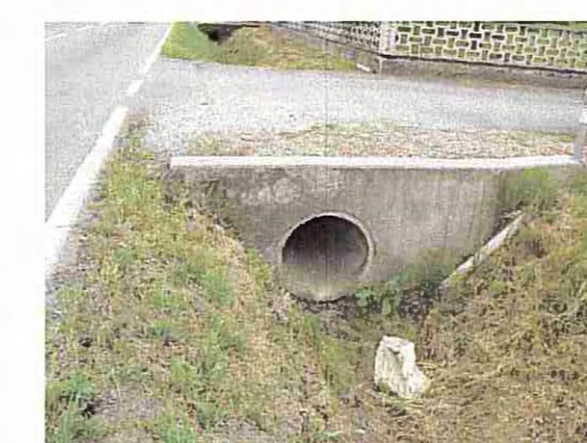
MANUFATTO M37 - LATO SUD
