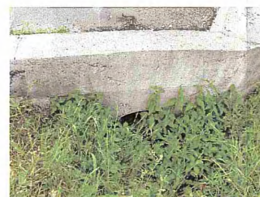
MANUFATTO M37 - LATO NORD
