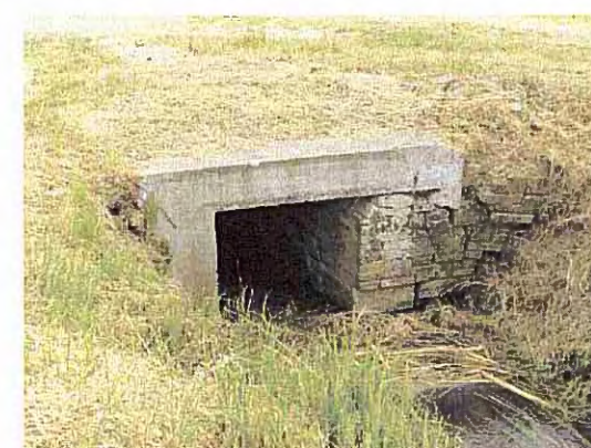
MANUFATTO M40 - LATO EST
