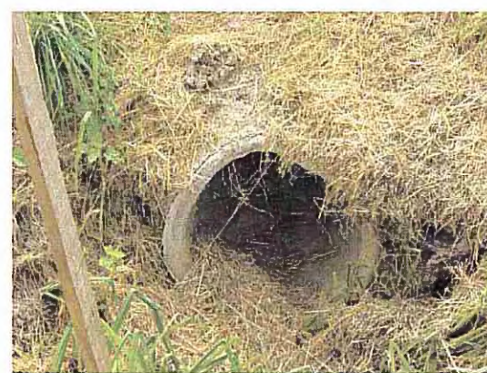
MANUFATTO M39 - LATO SUD
