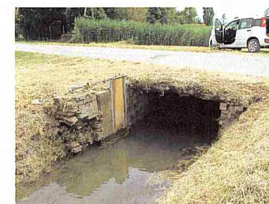
MANUFATTO M40 - LATO SUD
