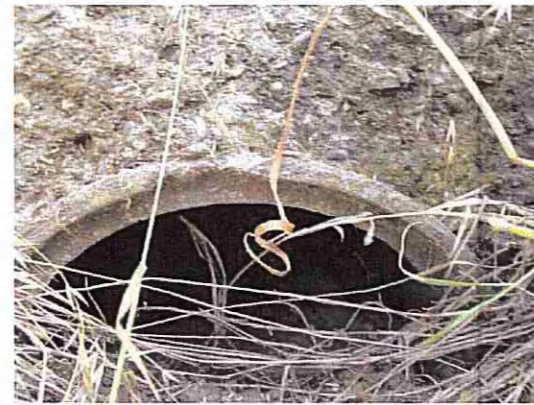
MANUFATTO M46 - LATO SUD
