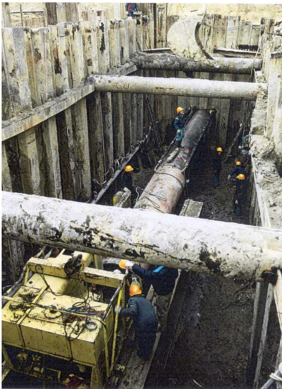
**Foto 5.1/L: Trivellazione con spingitubo**
