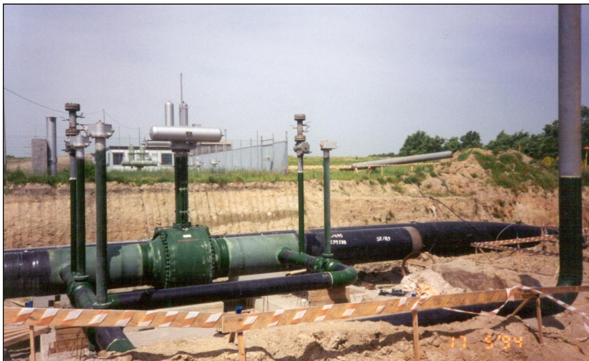
**Foto 5.1/N: Impianto di intercettazione di linea (PIL)**
