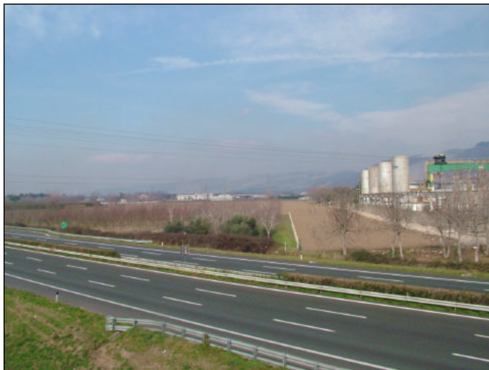
Figura 8 Impianti industriali nelle vicinanze dell'area impegnata dallo svincolo in progetto, lato est della A30, sullo sfondo si individuano i potenziali percettori
