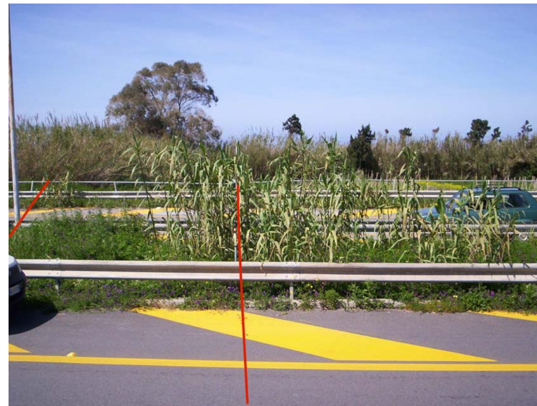
Foto 03: Attraversamento Strada litoranea consortile ASI
