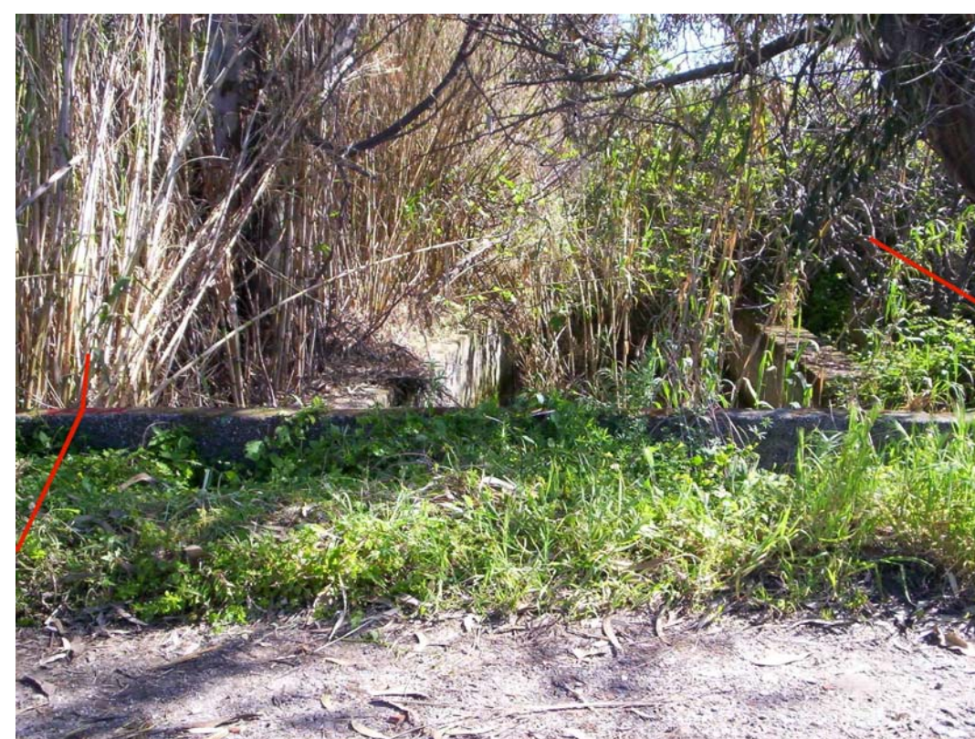
Foto 04: Panoramica del fosso al termine del tombino
