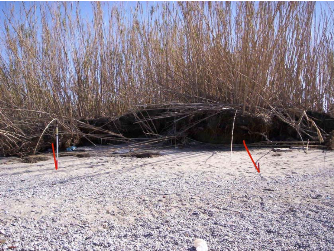
Foto 05: Panoramica punti terminali delle condotte
