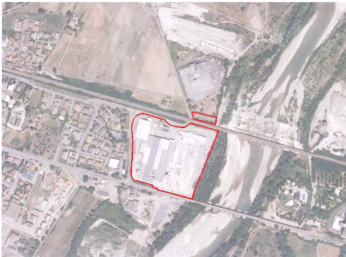
Vista aerea dell'area PTB
