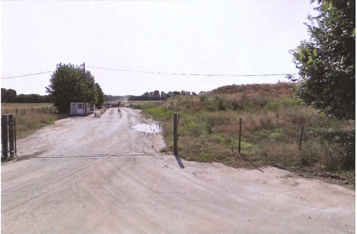
Accesso dalla strada Bianconese alla pista di cantiere che conduce all'area.
