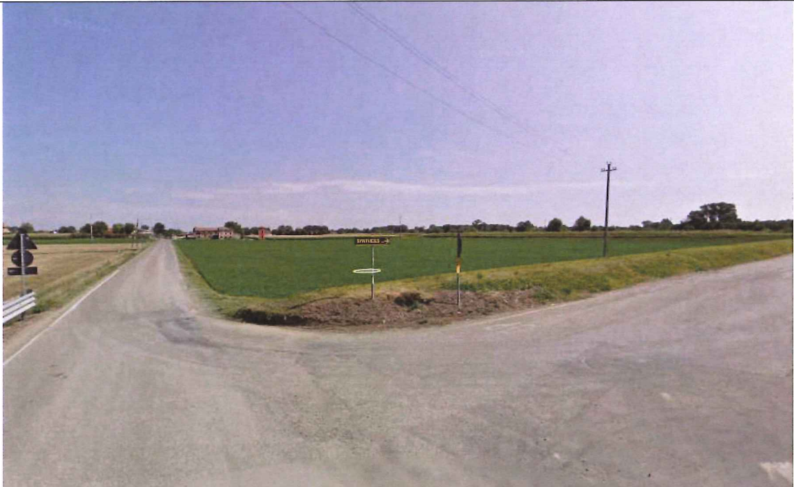
Accesso alle aree di cantiere da Strada Bianconese
