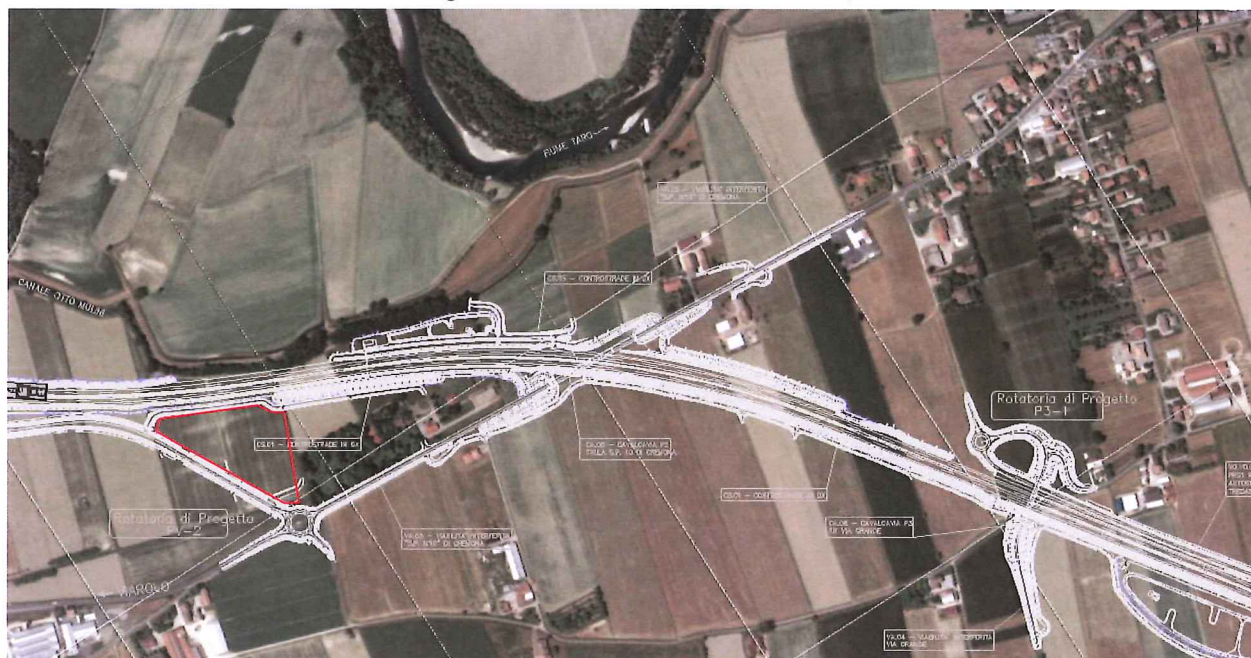
Vista aerea dell'area PV
