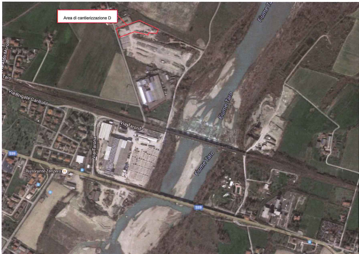
Vista aerea dell'area D
