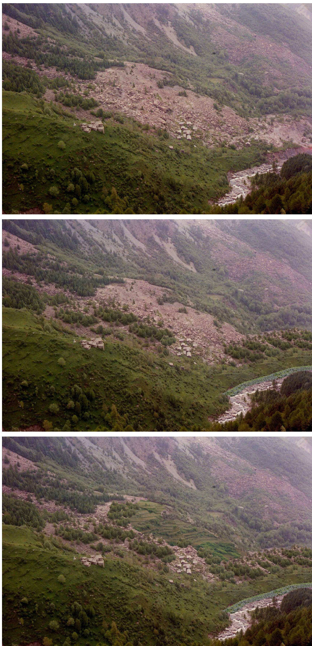
Figura E-8 – Versante sinistro orografico, zona frana B. Confronto tra la situazione attuale, quella di progetto I lotto e quella a completamento degli interventi di II lotto.
