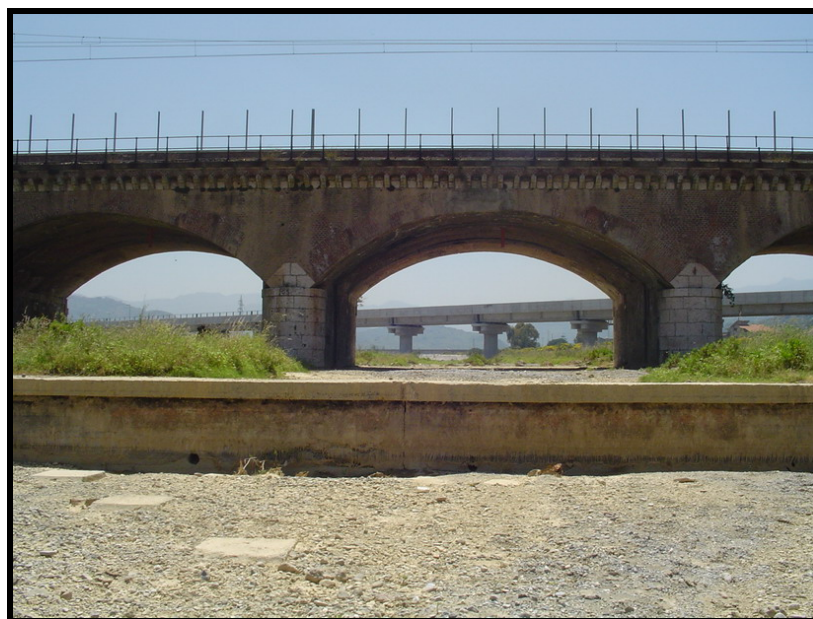
Foto 4.3.2-F Attraversamento SS113 e vecchia linea ferroviaria con briglia in primo piano (vista da lato mare)
