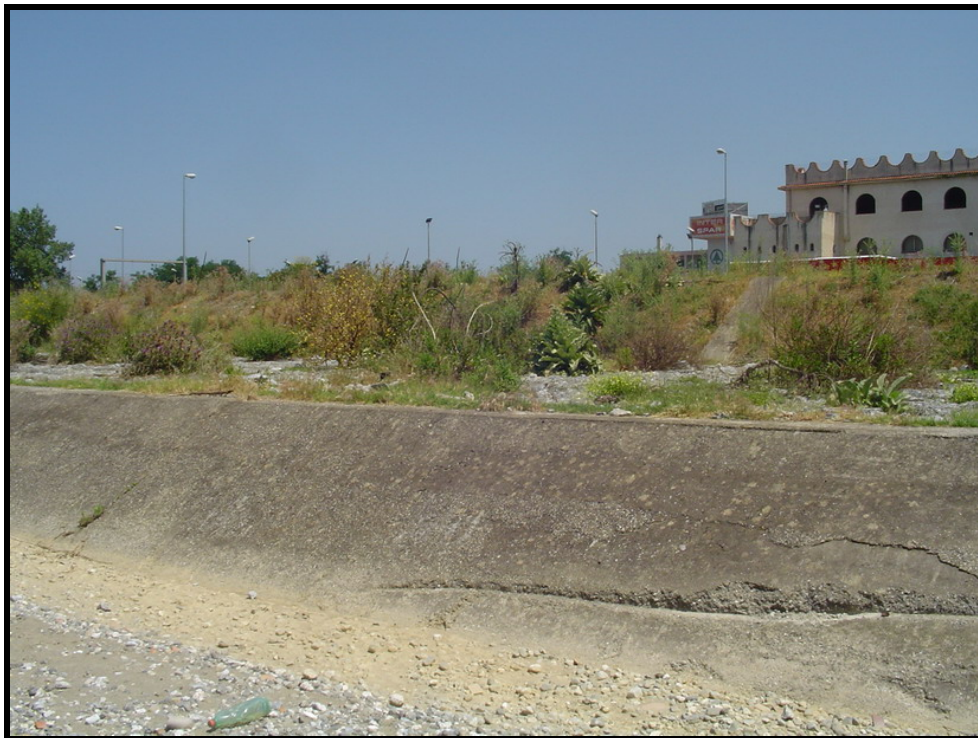
Foto 4.3.2-B – Particolare dell'arginatura della fiumara Niceto nel tratto a valle della SS113
