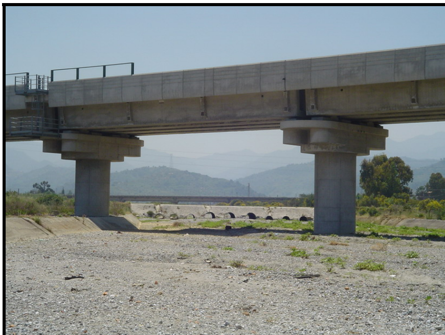
Foto 4.3.2-G Attraversamento nuova linea ferroviaria (vista da lato mare)
