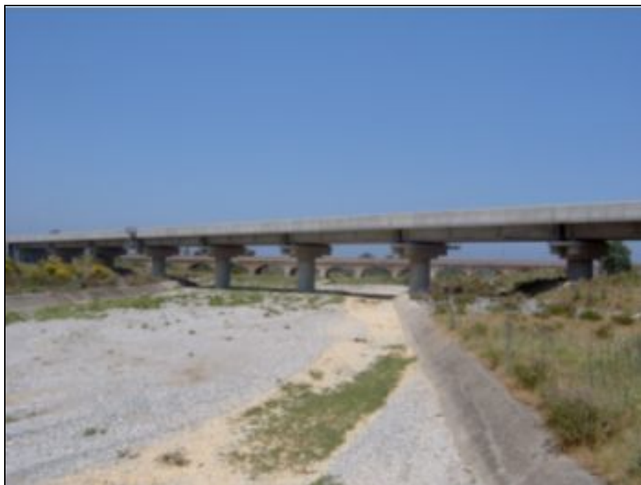
Foto 8.2-H Nuovo ponte sulla Fiumara Niceto a sud di quello ferroviario.
