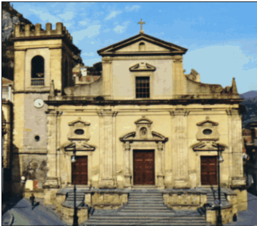
Foto 8.2-N Facciata della Chiesa madre S.Giorgio di Monforte (impianto:~1550)
