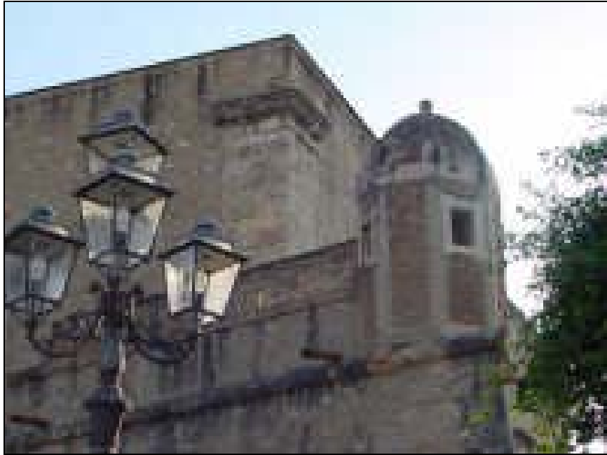
Foto 8.2-L Particolare architettonico del castello di Spadafora
