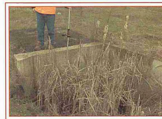
FOTO N. 33 - RACCORDO SU S.P.10
