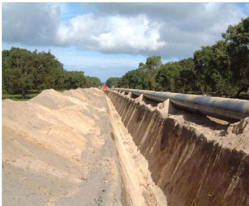
**Fig. 7.1.6-A** – Foto tipica di scavo della trincea
