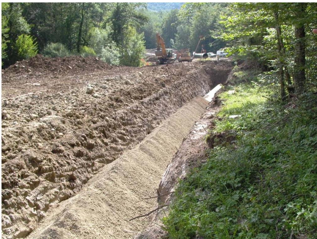
**Fig. 7.1.8-B** – Rinterro della condotta
