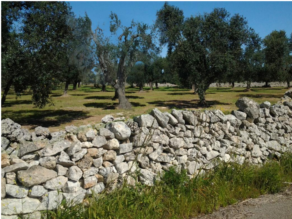
Fig. 3/C: Attraversamento areale a uliveti con muretto a secco. Ripristino effettuato
