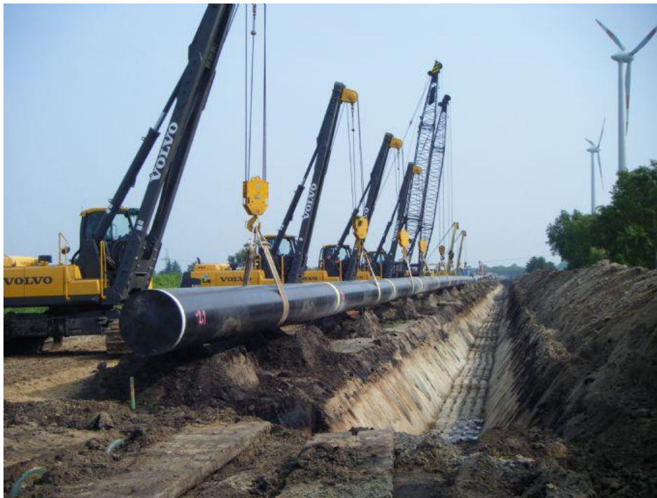
Fig. 8.1.8/A – Posa della condotta
