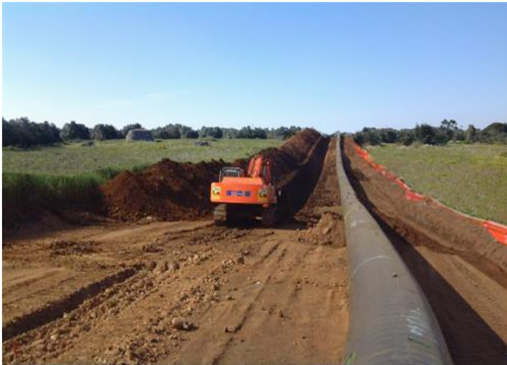
Fig. 3/E: Attraversamento area prativa. Cantiere in corso
