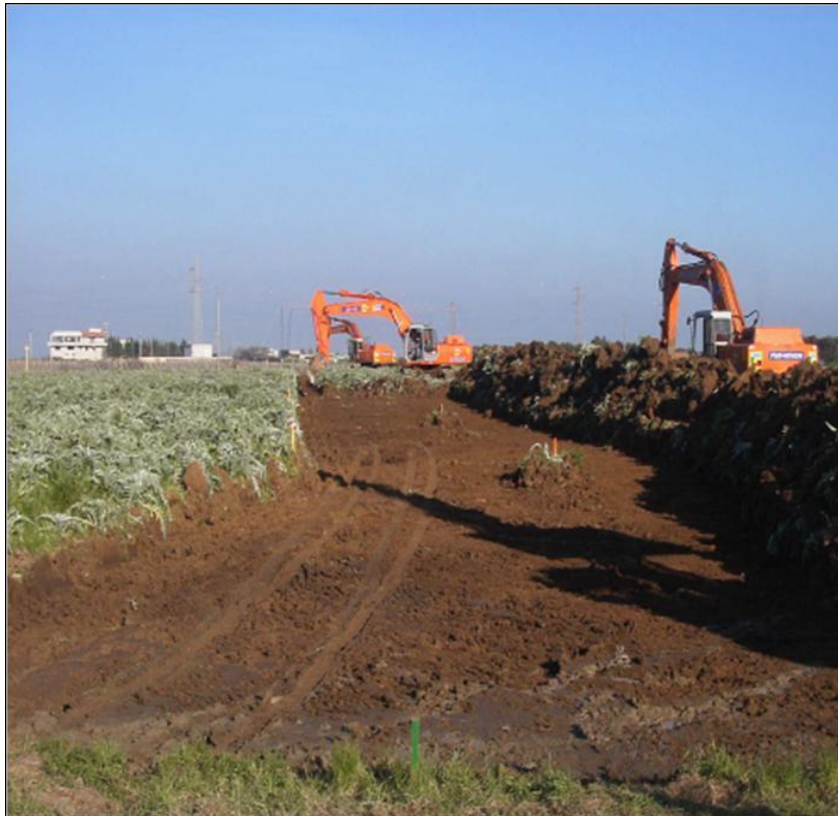
Fig. 8.1.2/A – Foto di apertura dell'area di passaggio
