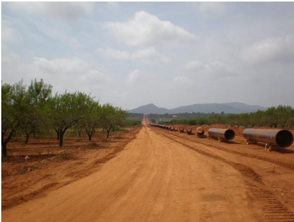
Fig. 8.1.4/A –Sfilamento tubazioni
