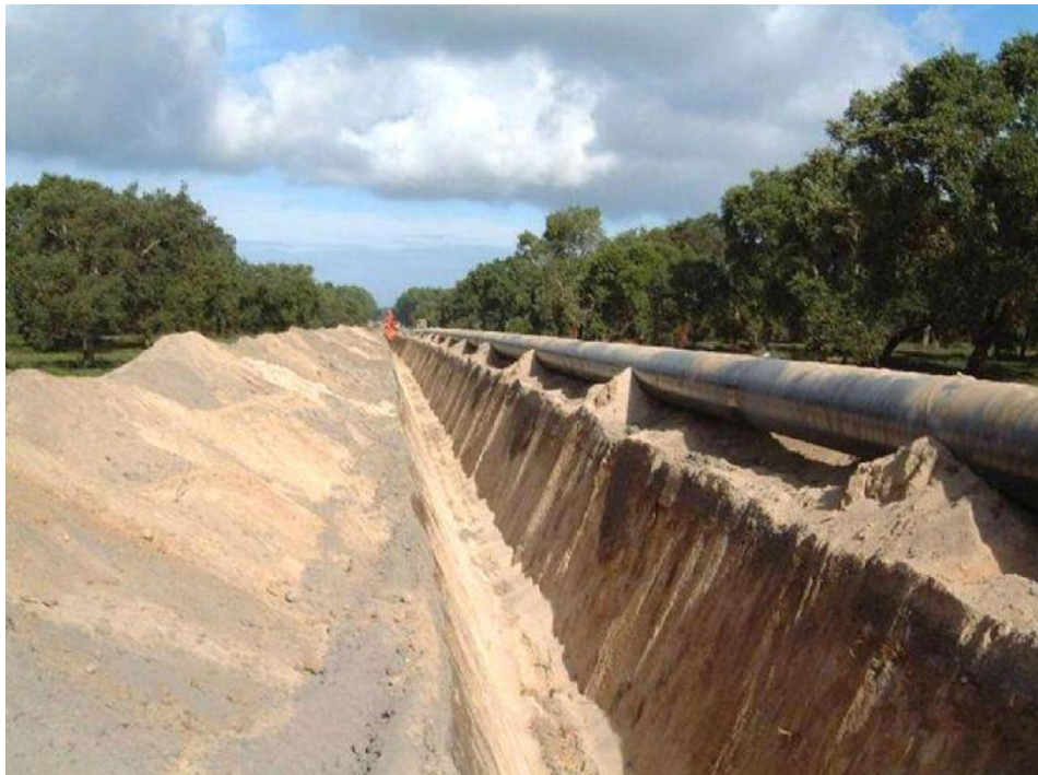
Fig. 8.1.6/A – Foto tipica di scavo della trincea
