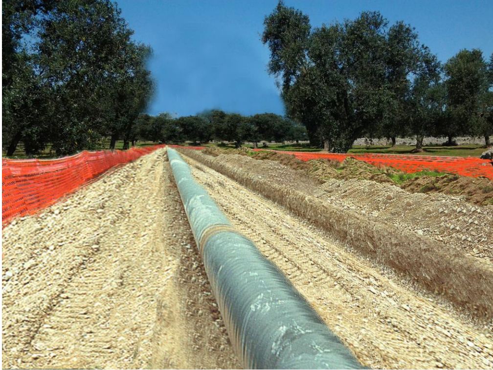
Fig. 3/B: Attraversamento areale a uliveti con muretto a secco. Cantiere in corso
