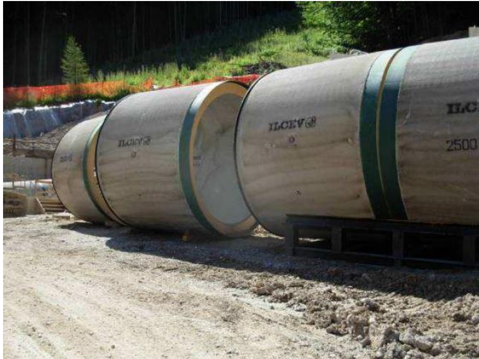
Fig. 8.1.10/F – Stoccaggio tubi in c.a.
