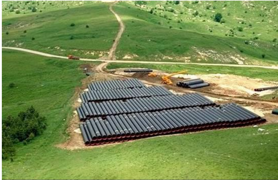
Fig. 8.1.1/A – Foto tipica di una piazzola per accatastamento tubazioni
