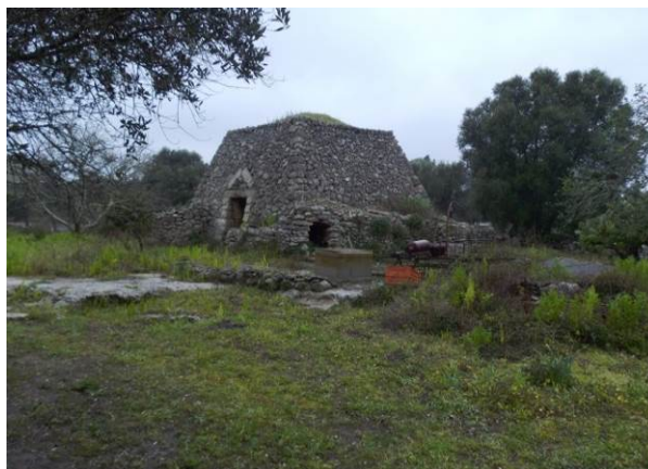
Fig. III 1.6/B – "pagghiara" a pianta rettangolare nei pressi del tracciato, in comune di Melendugno
