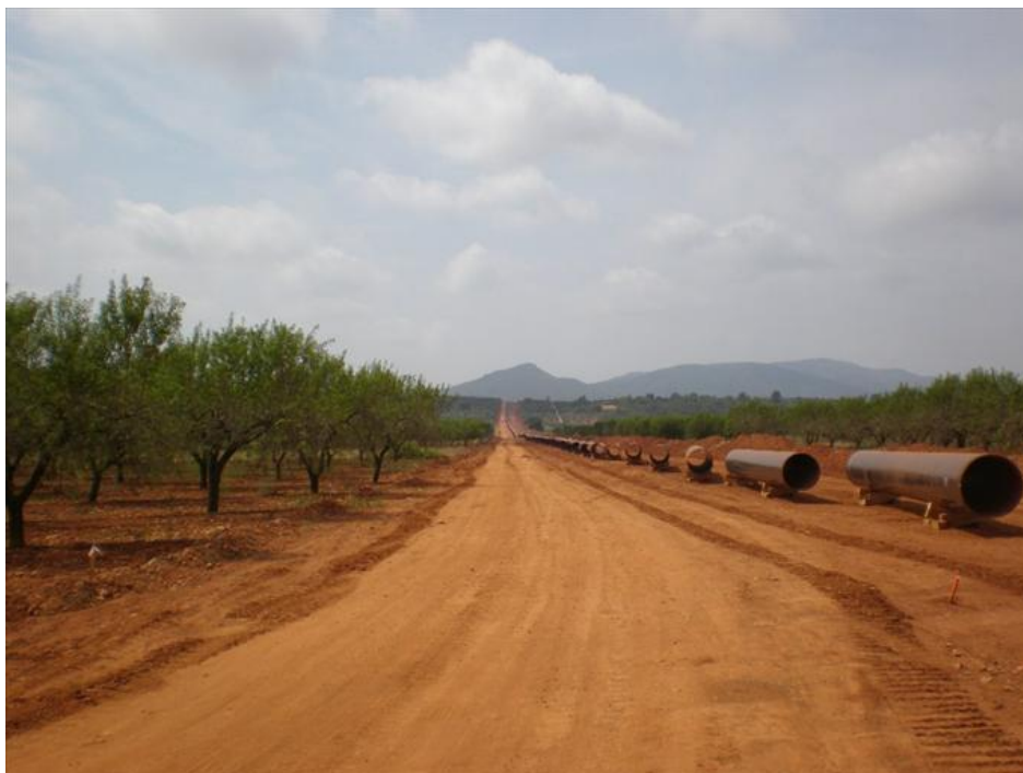
Fig. II 5.1.4/A – Sfilamento tubazioni
