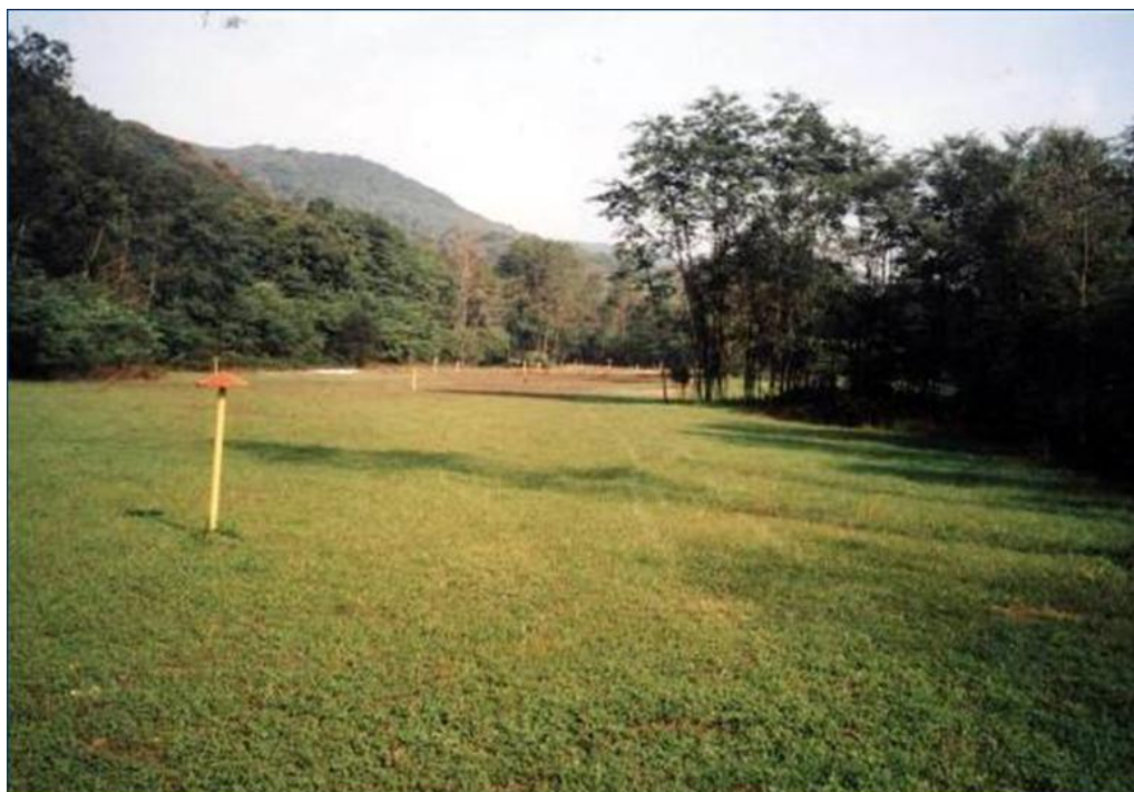
Fig. II 5.1.13/A – Pista lavori a ripristini ultimati su un gasdotto in esercizio
