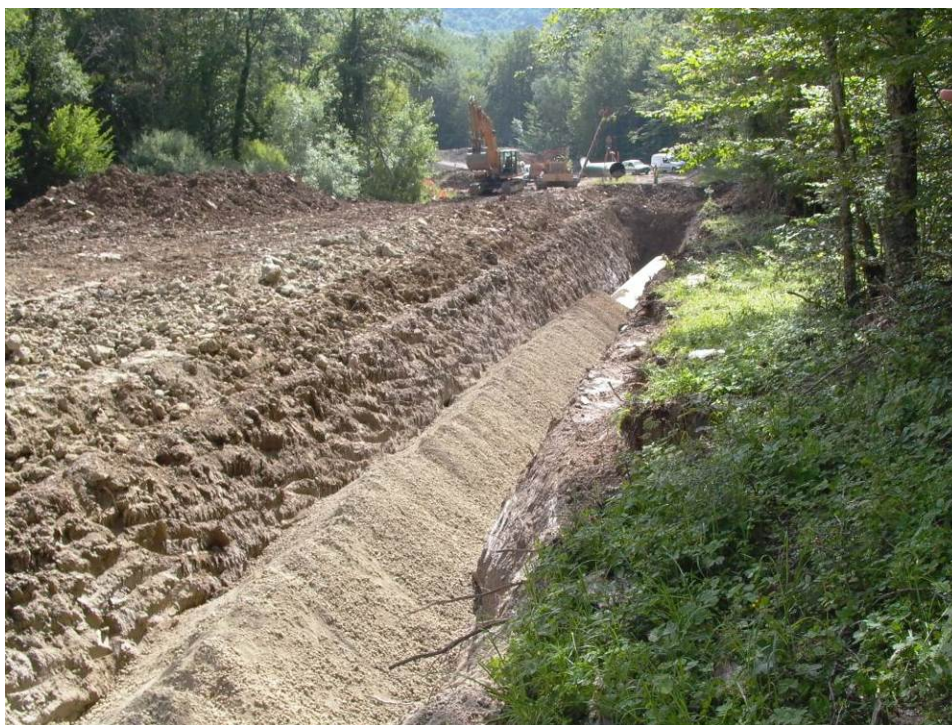
Fig. II 5.1.8/B –Rinterro della condotta
