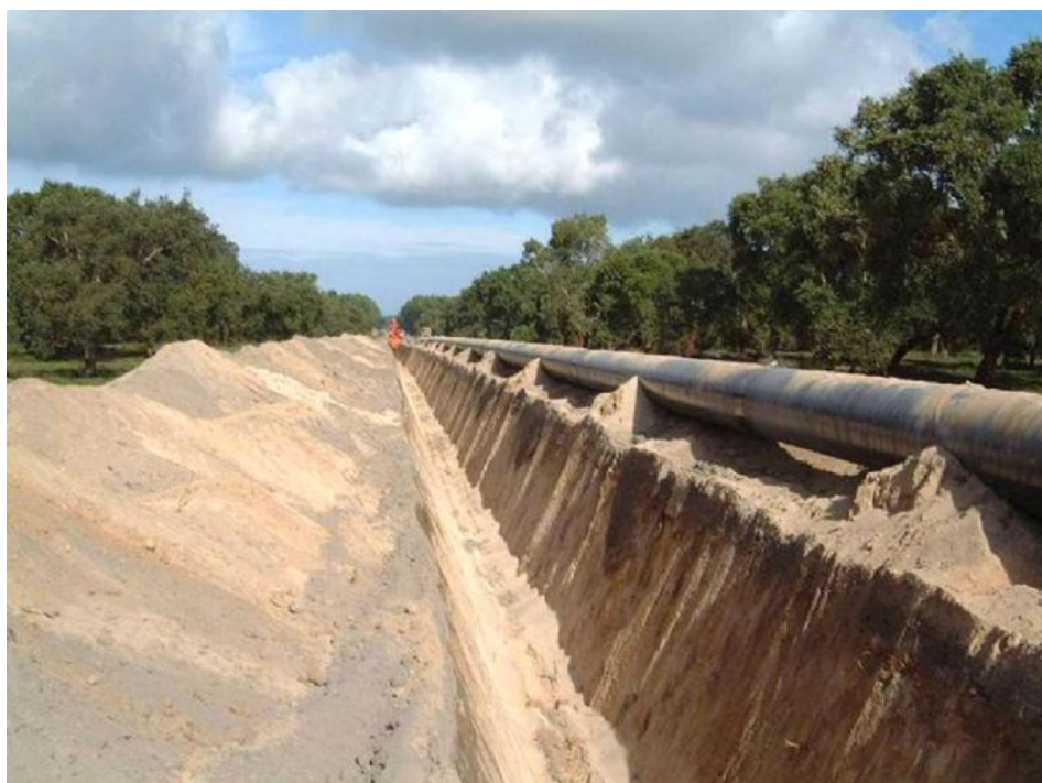
Fig. II 5.1.6/A – Foto tipica di scavo della trincea
