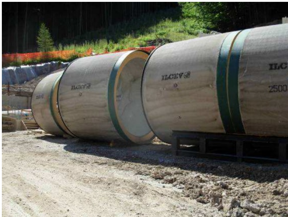
Fig. II 5.1.10/F – Stoccaggio tubi in c.a.
