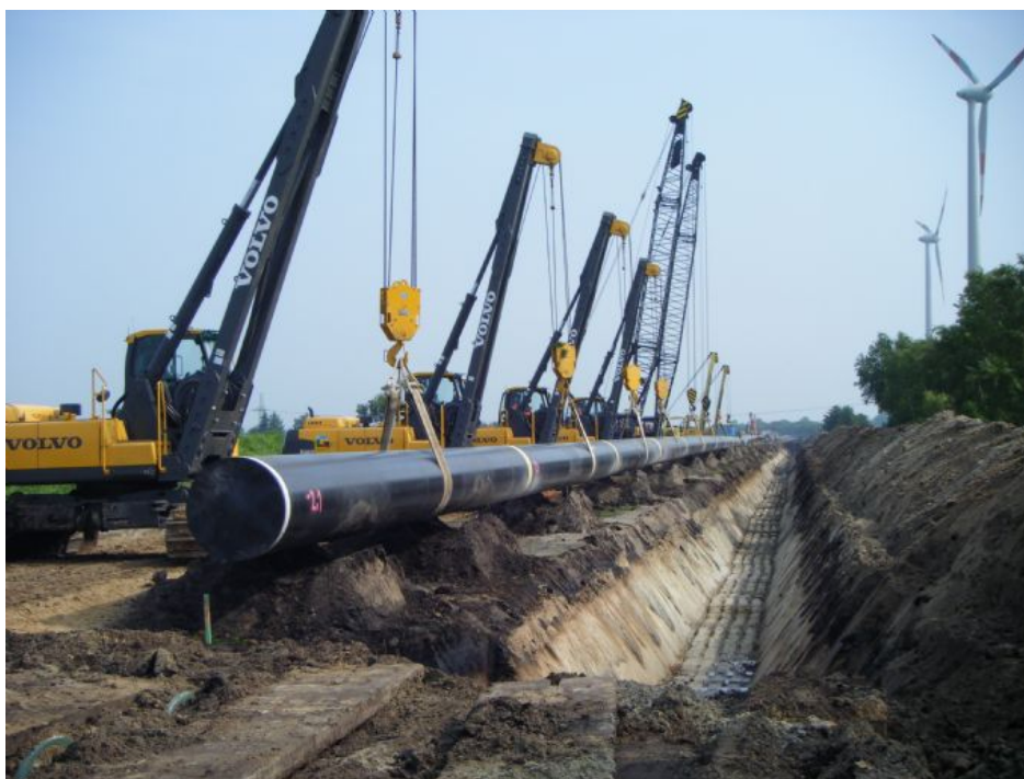
Fig. II 5.1.8/A – Posa della condotta
