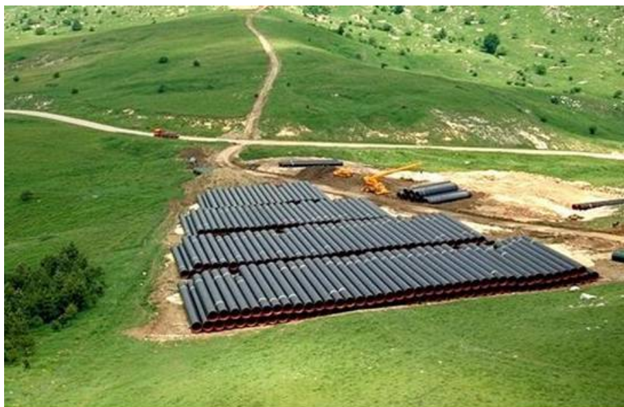
Fig. II 5.1.1/A – Foto tipica di una piazzola per accatastamento tubazioni
