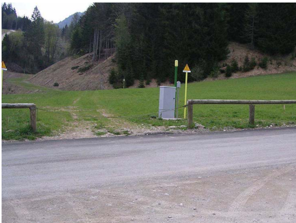
Fig. II 9/A - I cartelli segnalatori del metanodotto ed i tubi di sfiato posti in corrispondenza degli attraversamenti eseguiti con tubo di protezione.
