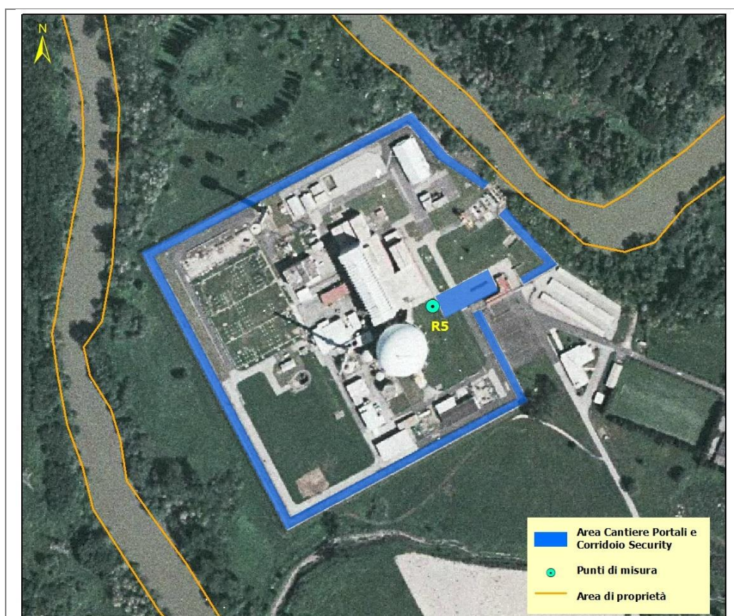
Figura 7-1 - Punti di misura in prossimità delle aree di cantiere "Portali"
