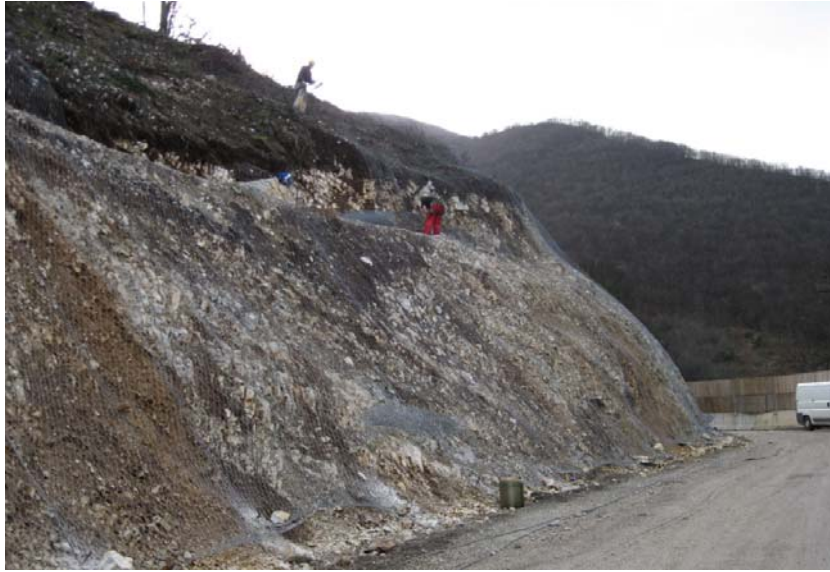
Figura 10 - Immagine della pista in fase di produzione
