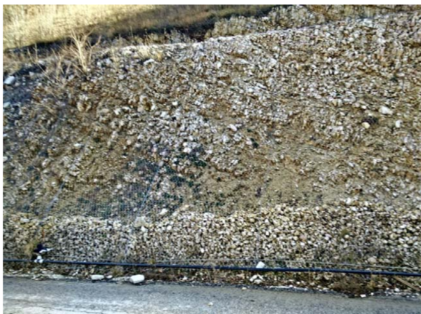
Figura 9 - Immagine della pista in fase di produzione
