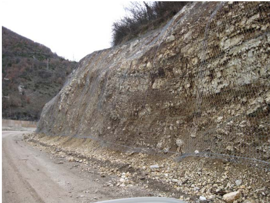
Figura 11 - Immagine della pista in fase di produzione
