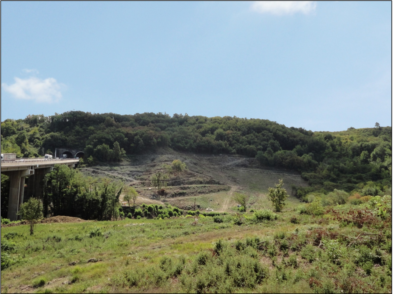
Foto relativa allo stato dell'area d'intervento all'inizio dei lavori (sondaggi e lavori preparatori)
