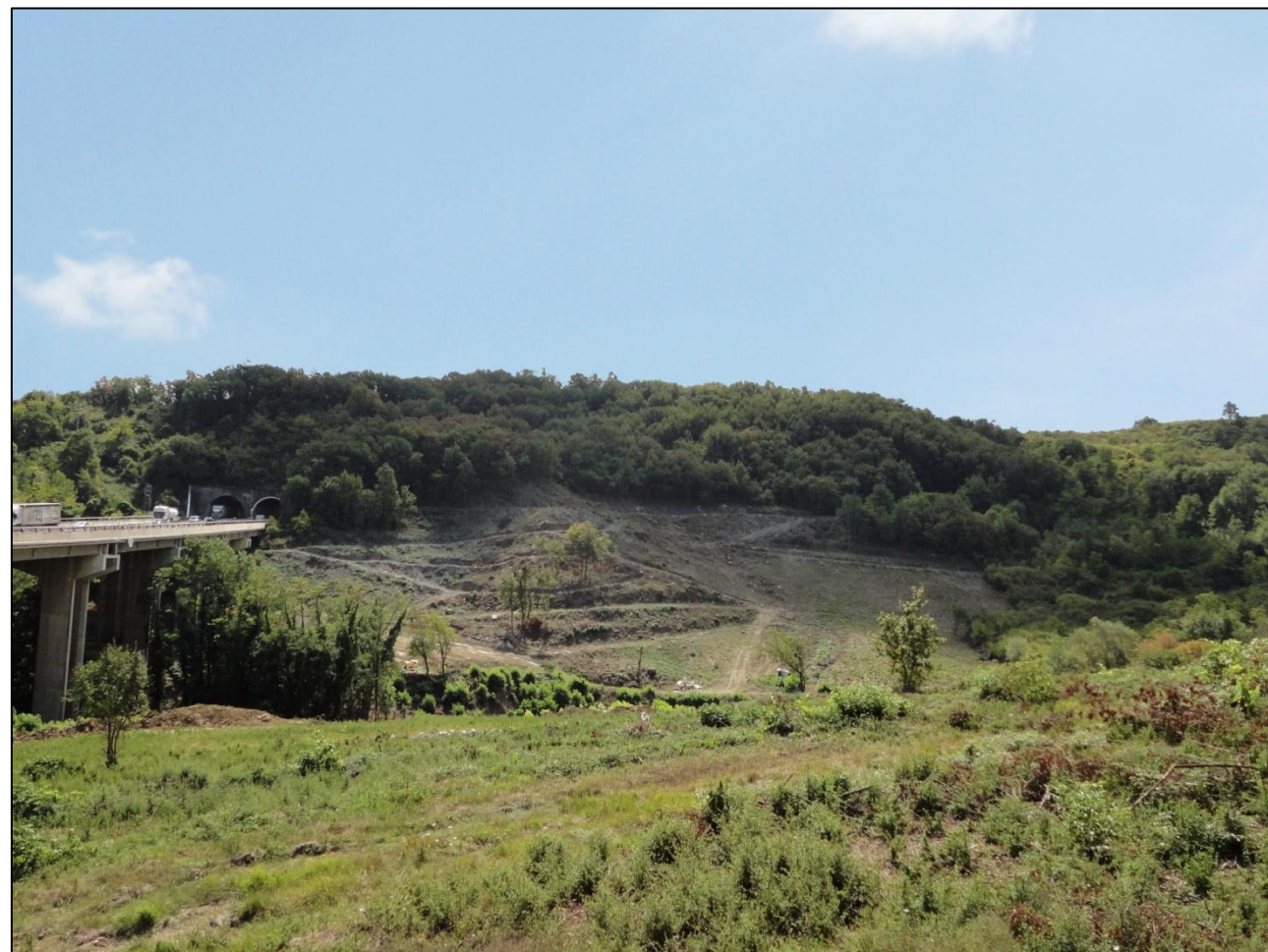
Figura 4: foto relativa allo stato dell'area d'intervento esistente all'inizio della realizzazione degli interventi già approvati e realizzati nell'ambito dei lavori di ampliamento autostradale del tratto Barberino di Mugello – Firenze Nord
