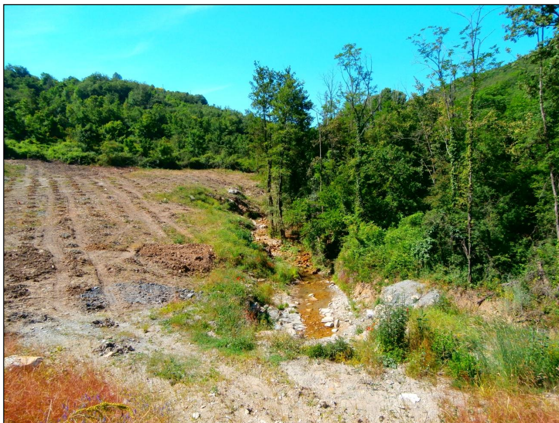
Figura 24: foto Fosso Baccheraia nel tratto a monte rispetto al cantiere
