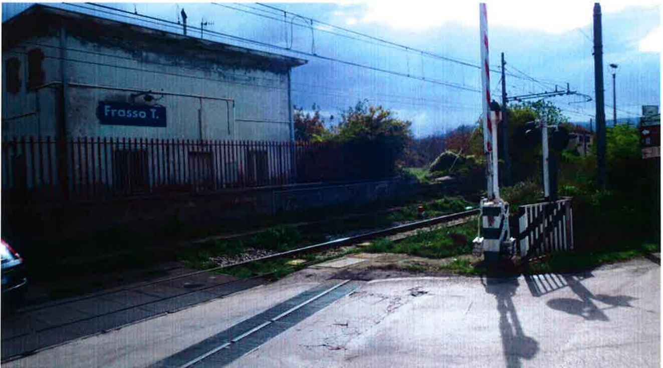
Foto 1 – Immagine del passaggio a livello oggetto di soppressione.
