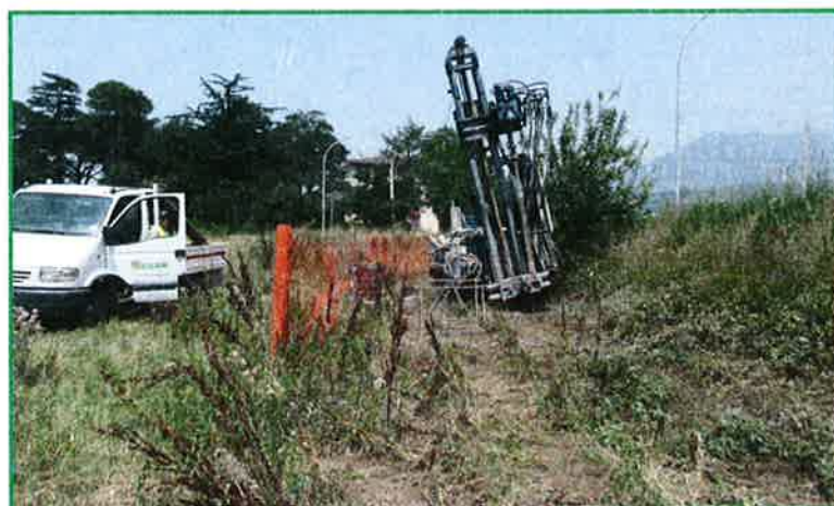
Sondaggio S3: Avanzamento sondaggio
