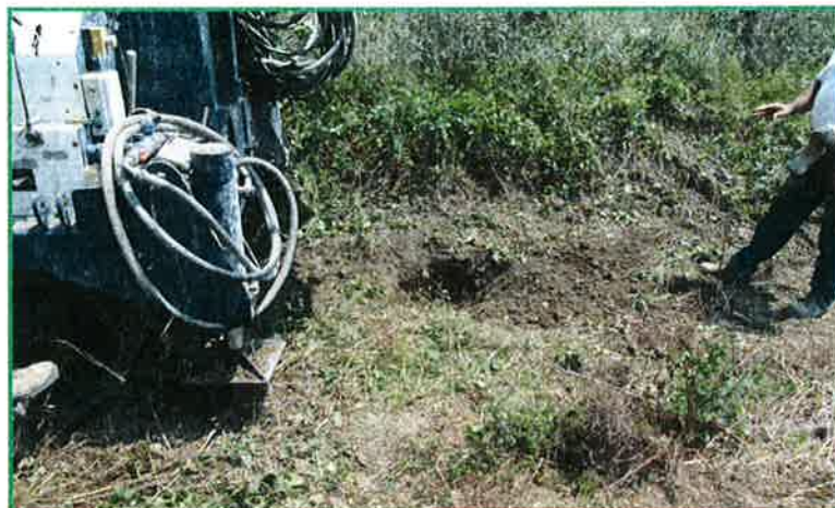
Sondaggio S3: Prescavo
