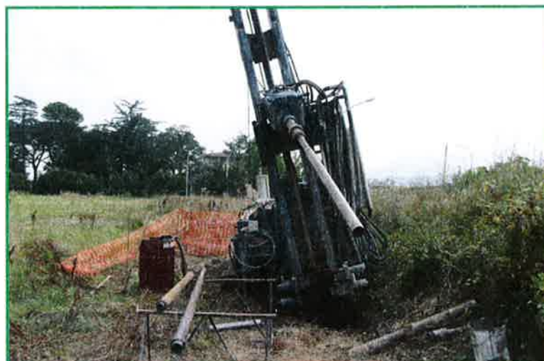
Sondaggio S4: Avanzamento sondaggio
