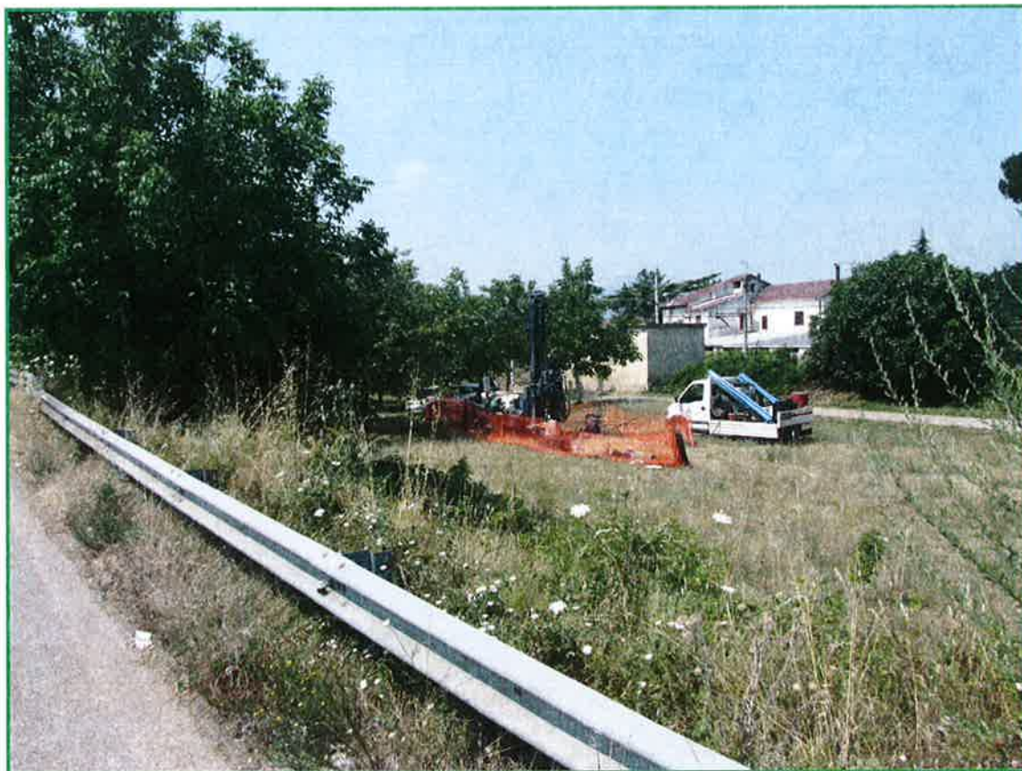
Sondaggio S2: Postazione
