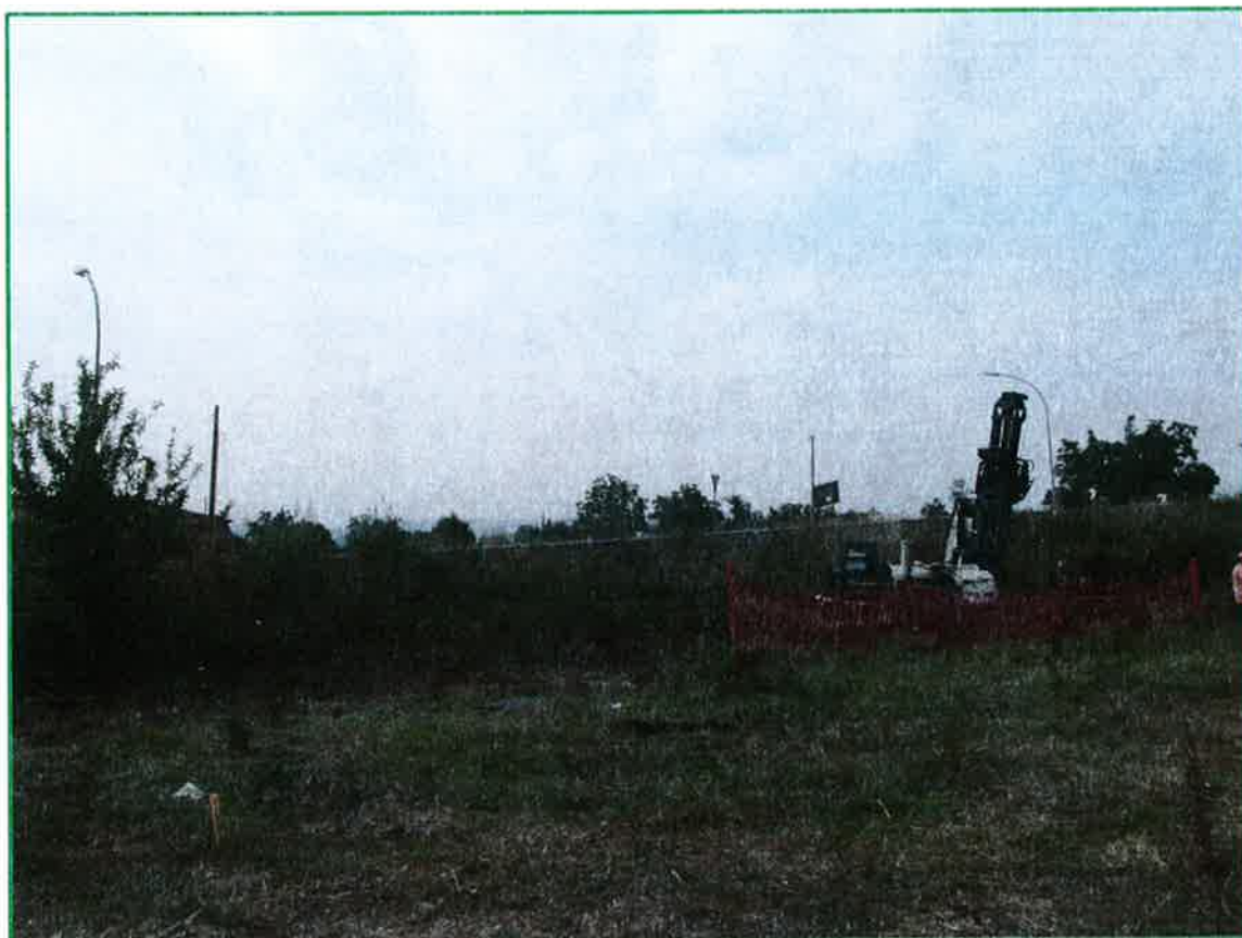
Sondaggio S4: Postazione
