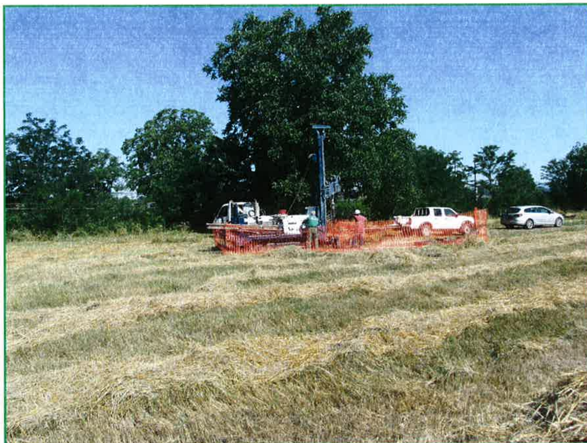
Sondaggio S1: Postazione
