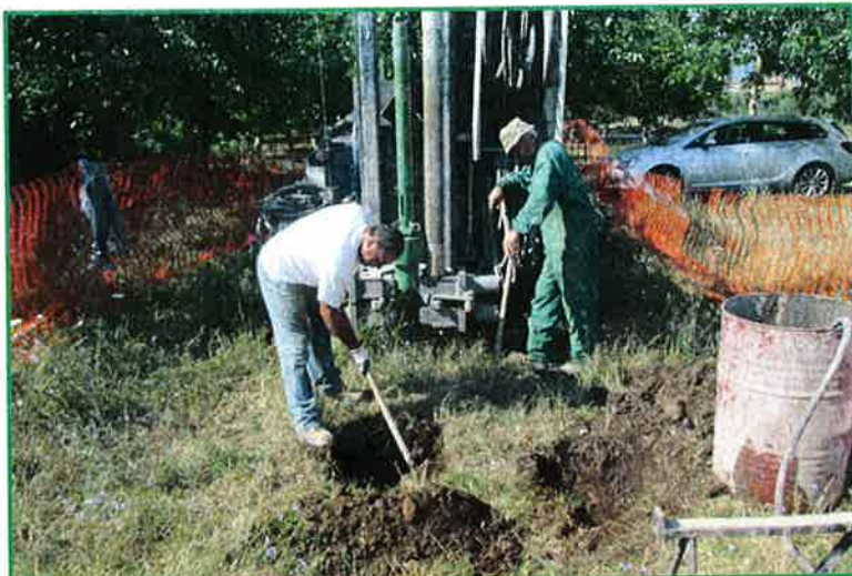
Sondaggio S2: Prescavo
