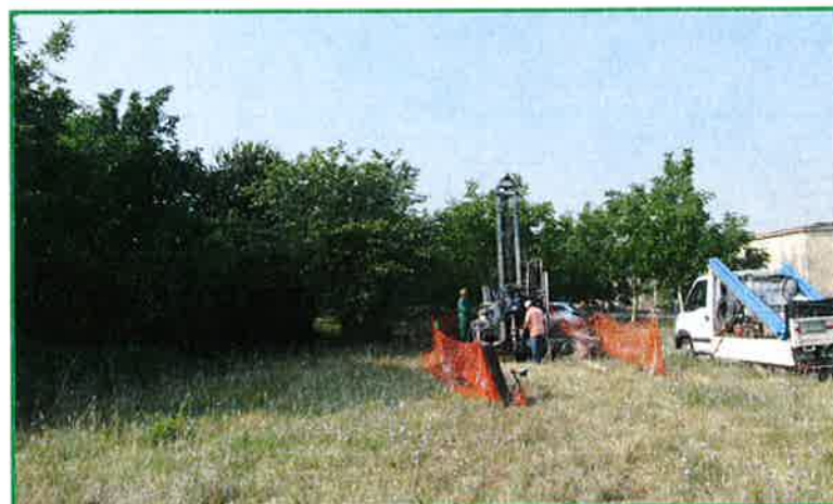
Sondaggio S2: Avanzamento sondaggio
