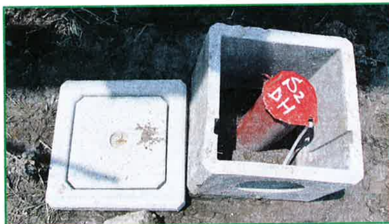
Sondaggio S2: Pozzetto di protezione tubo Down Hole con chiusino
