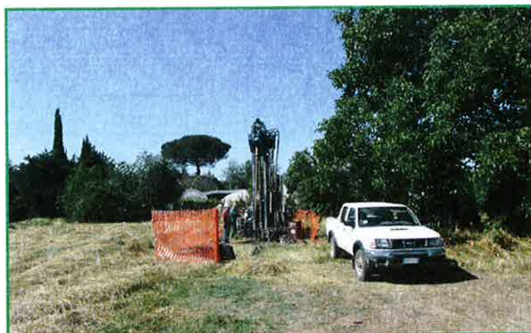
Sondaggio S1: Avanzamento sondaggio
