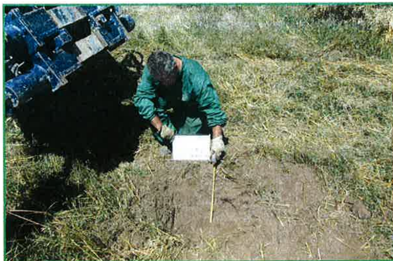
Sondaggio S1: Prescavo
