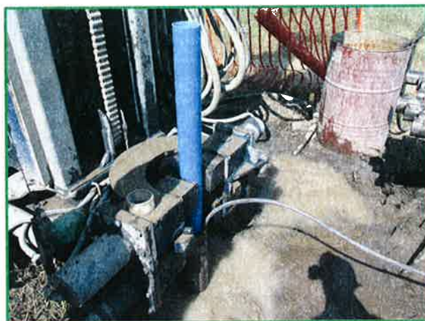
Figura 5: Installazione tubo Down Hole
