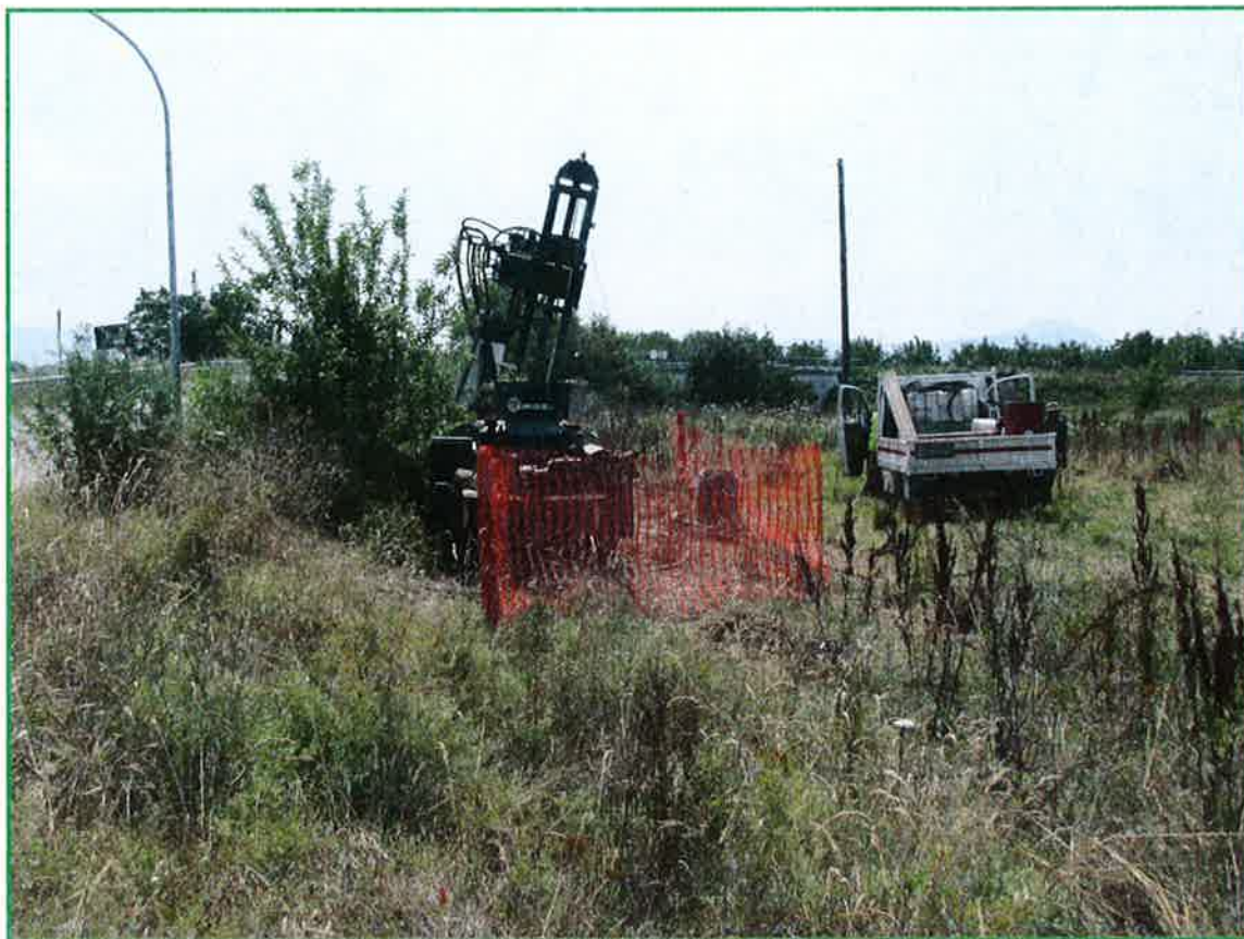
Sondaggio S2: Postazione
