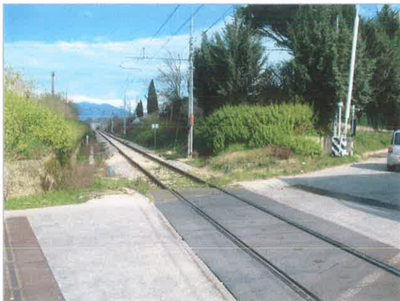
Foto - P.L. al km 143+833
