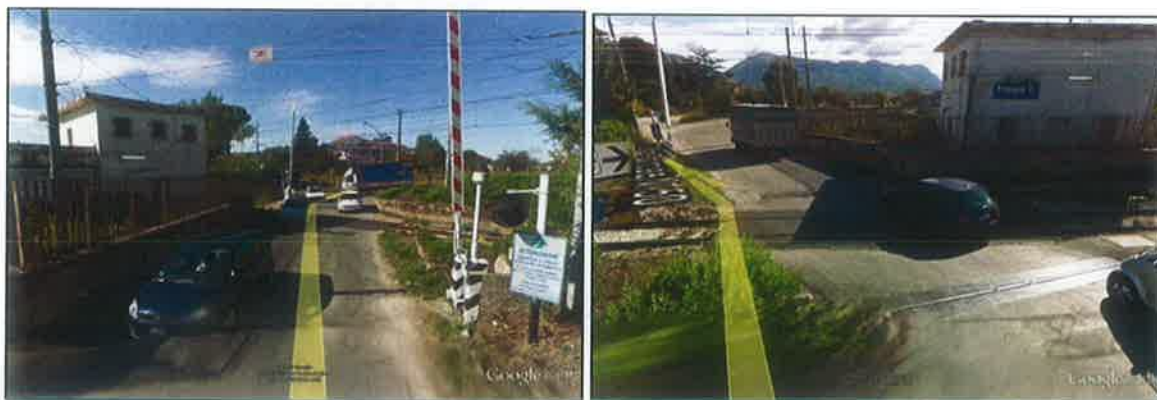
Figura 2-4: Passaggio a livello attuale
